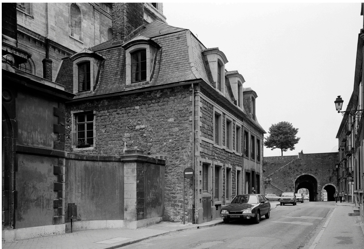
Vue d'angle sud-ouest.
