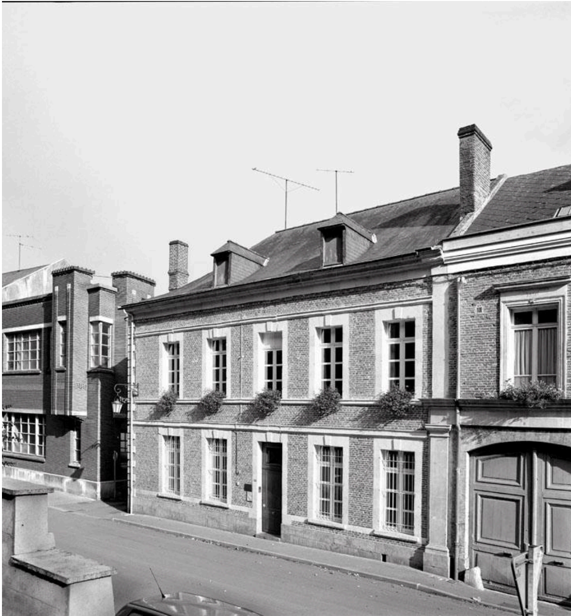
Vue de la façade de la maison située rue Chantraine (N°165).
