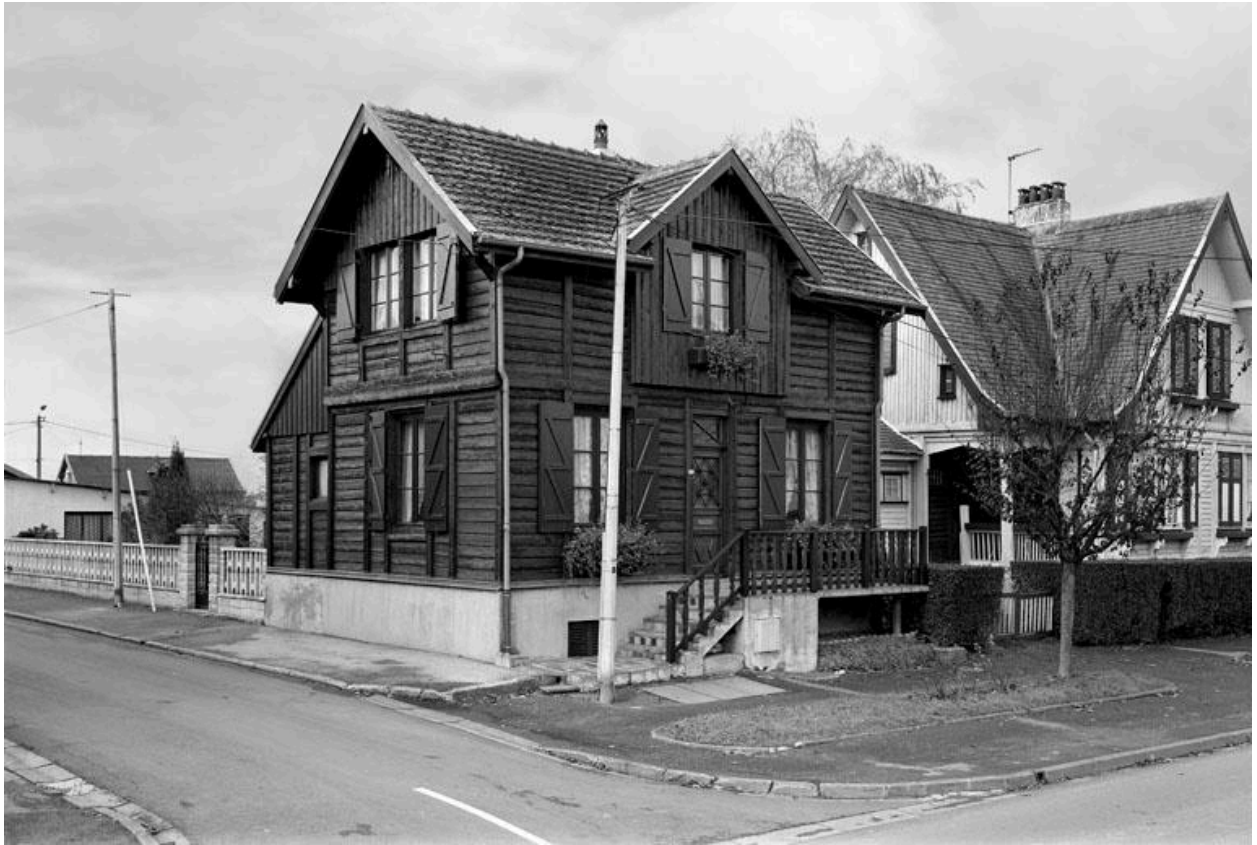
Vue de la façade postérieure de la maison située rue de la République (N°99).
