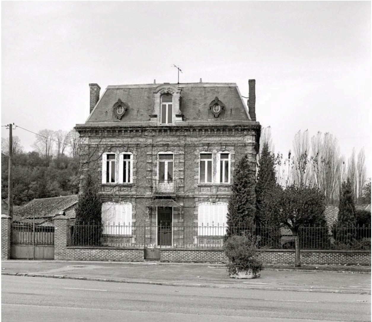
Vue de la façade de la maison située boulevard Jean-Jaurès (N°179).
