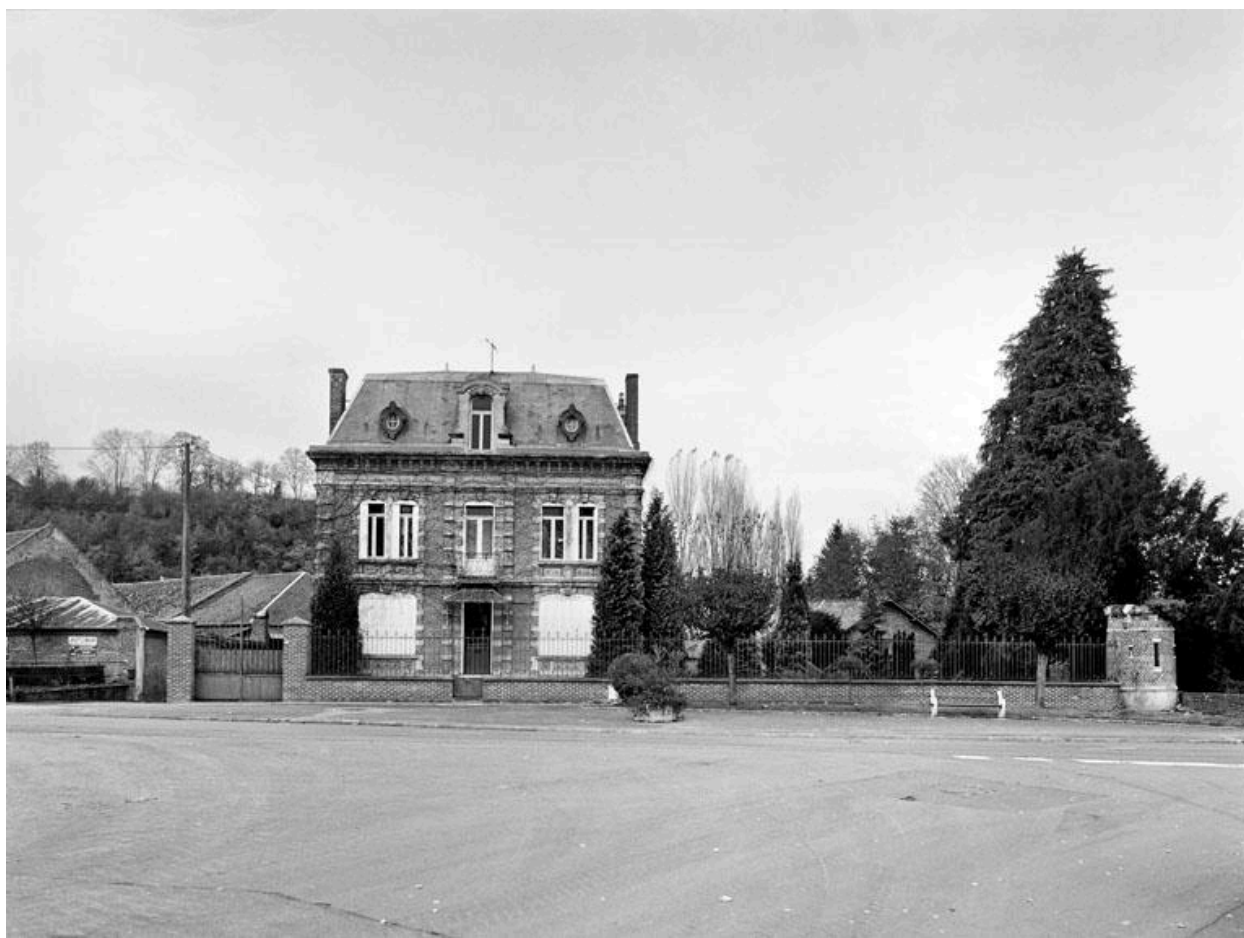
Vue de la façade de la maison située boulevard Jean-Jaurès (N°179).
