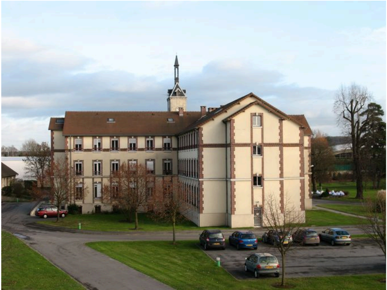
La maison de retraite Saint-Vincent-de-Paul construite à l'emplacement du moulin à farine en 1886.
