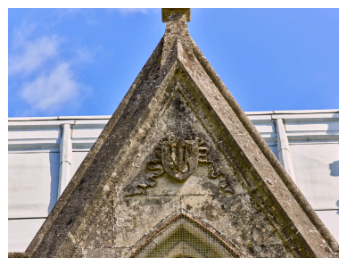
Détail des initiales sur le gable de la baie sud. Phot. Thierry Lefébure IVR32_20248001270NUCA
