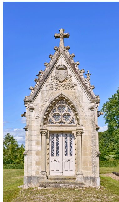
Élévation est de la chapelle funéraire. Phot. Thierry Lefébure IVR32_20248001251NUCA
