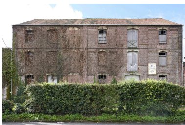
Façade sur rue. Phot. Delphine Volto Jourdan IVR32_20245903248NUCA
