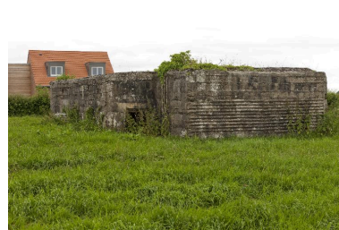
Elévation est et sud Phot. Jean-Marc Ramette IVR31_20145905339NUCA
