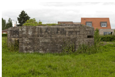
Elévation est Phot. Jean-Marc Ramette IVR31_20145905337NUCA
