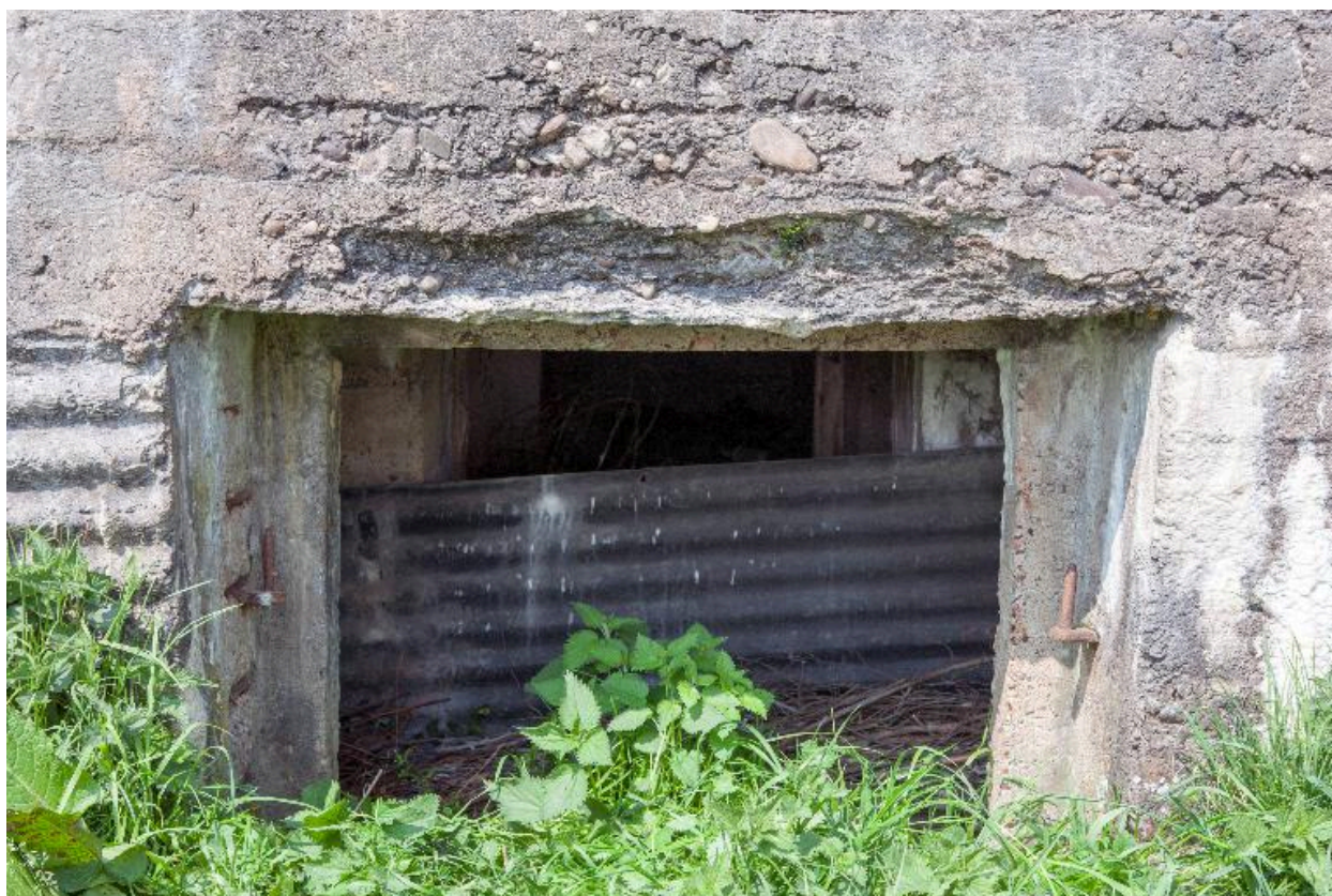
Elévation sud, entrée centrale
