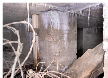
Depuis le couloir de distribution, la niche à gauche et l'accès à la salle ouest, à droite Phot. Pierre Thibaut IVR32_20165901691NUCA
