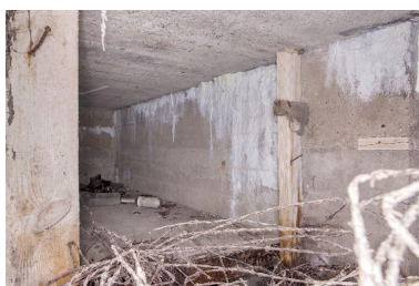
Depuis le couloir de distribution, la niche centrale. Phot. Pierre Thibaut IVR32_20165901690NUCA
