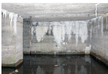
La salle ouest. Dans le fond, à gauche, l'accès au poste d'observation (?) Phot. Pierre Thibaut IVR31_20155901153NUCA
