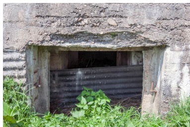
Elévation sud, entrée centrale
