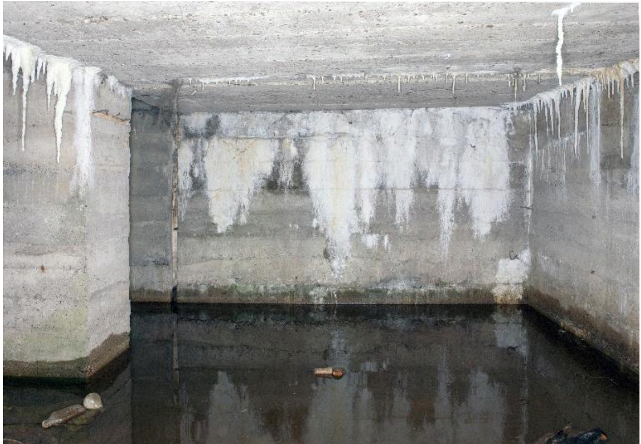
La salle ouest. Dans le fond, à gauche, l'accès au poste d'observation (?)
