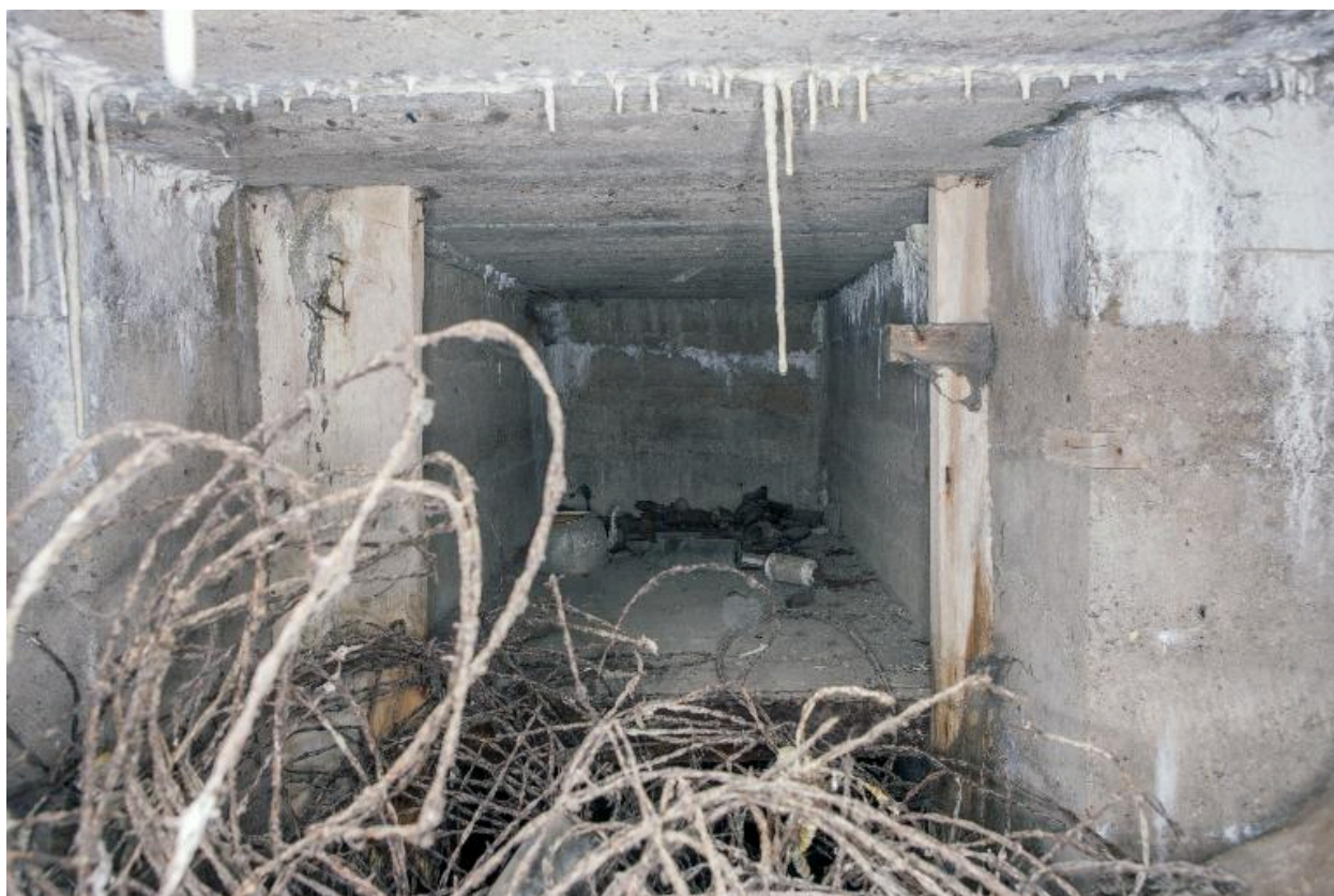
Débouché de l'entrée sud dans le couloir de distribution. En face une grande niche.
