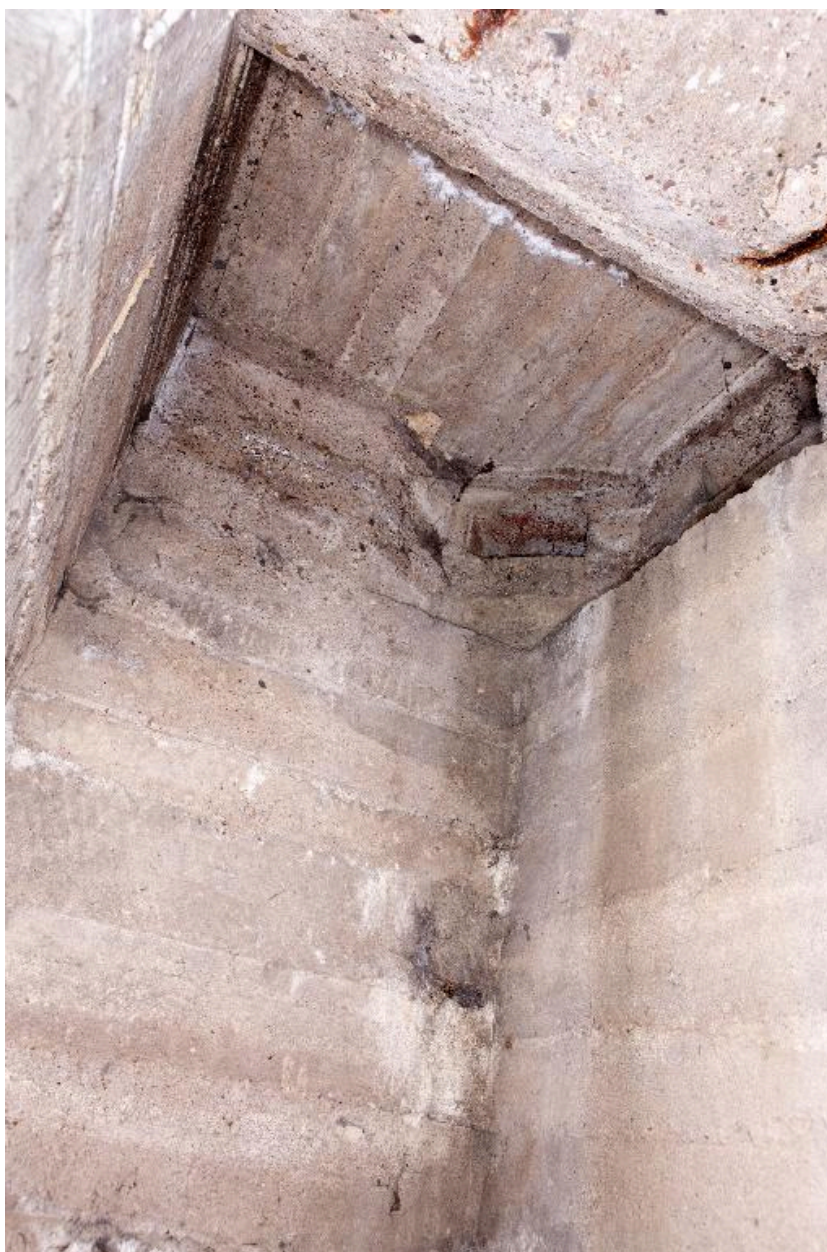
Salle ouest, en contre plongée, l'observatoire
