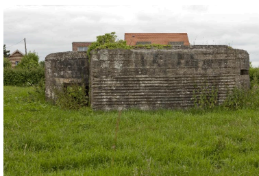
Elévation est avec couloir pare-éclats à gauche et observatoire à droite Phot. Jean-Marc Ramette IVR31_20145905338NUCA
