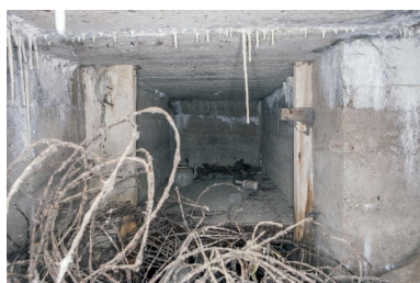
Débouché de l'entrée sud dans le couloir de distribution. En face une grande niche. Phot. Pierre Thibaut IVR31_20155901157NUCA
