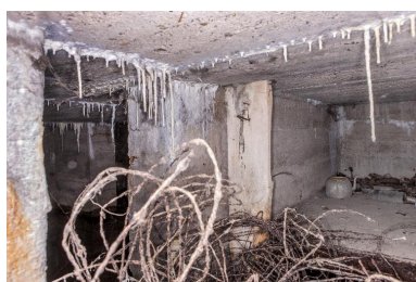
Depuis le couloir de distribution, la niche à droite et l'accès à la salle ouest, à gauche Phot. Pierre Thibaut IVR32_20165901689NUCA
