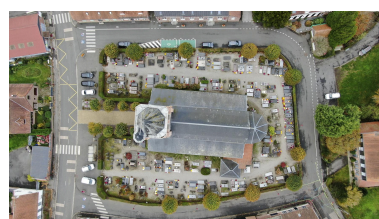
Vue zénithale du contour de l'église. Phot. Delphine Volto Jourdan IVR32_20245906704NUCA
