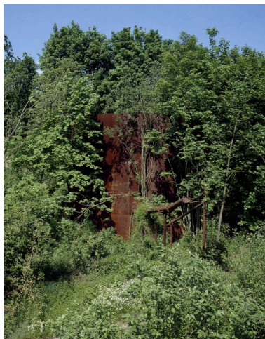
Vestiges du réservoir industriel. Phot. Patrick Glotain IVR22_19936001822XA
