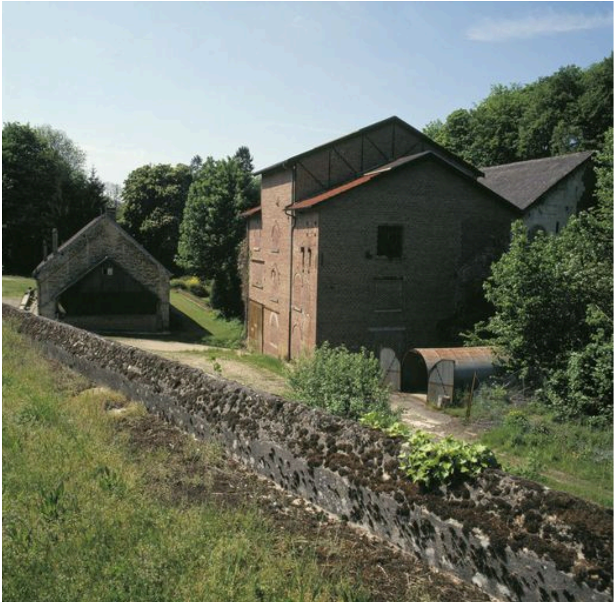
Bâtiment de l'ancienne distillerie d'alcool, vue d'ensemble sud.
