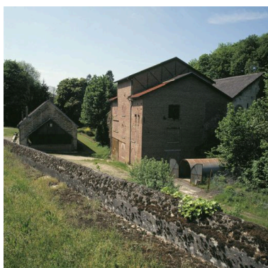
Bâtiment de l'ancienne distillerie d'alcool, vue d'ensemble sud. Phot. Patrick Glotain IVR22_19936001825XA
