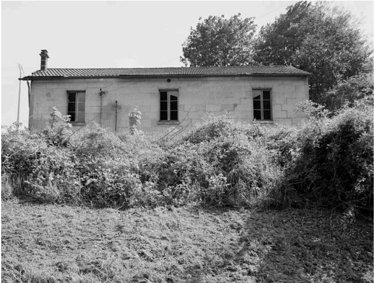
Logement d'ouvriers : façade nord.
