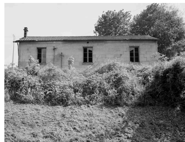
Logement d'ouvriers : façade nord. Phot. Patrick Glotain IVR22_19936000568X
