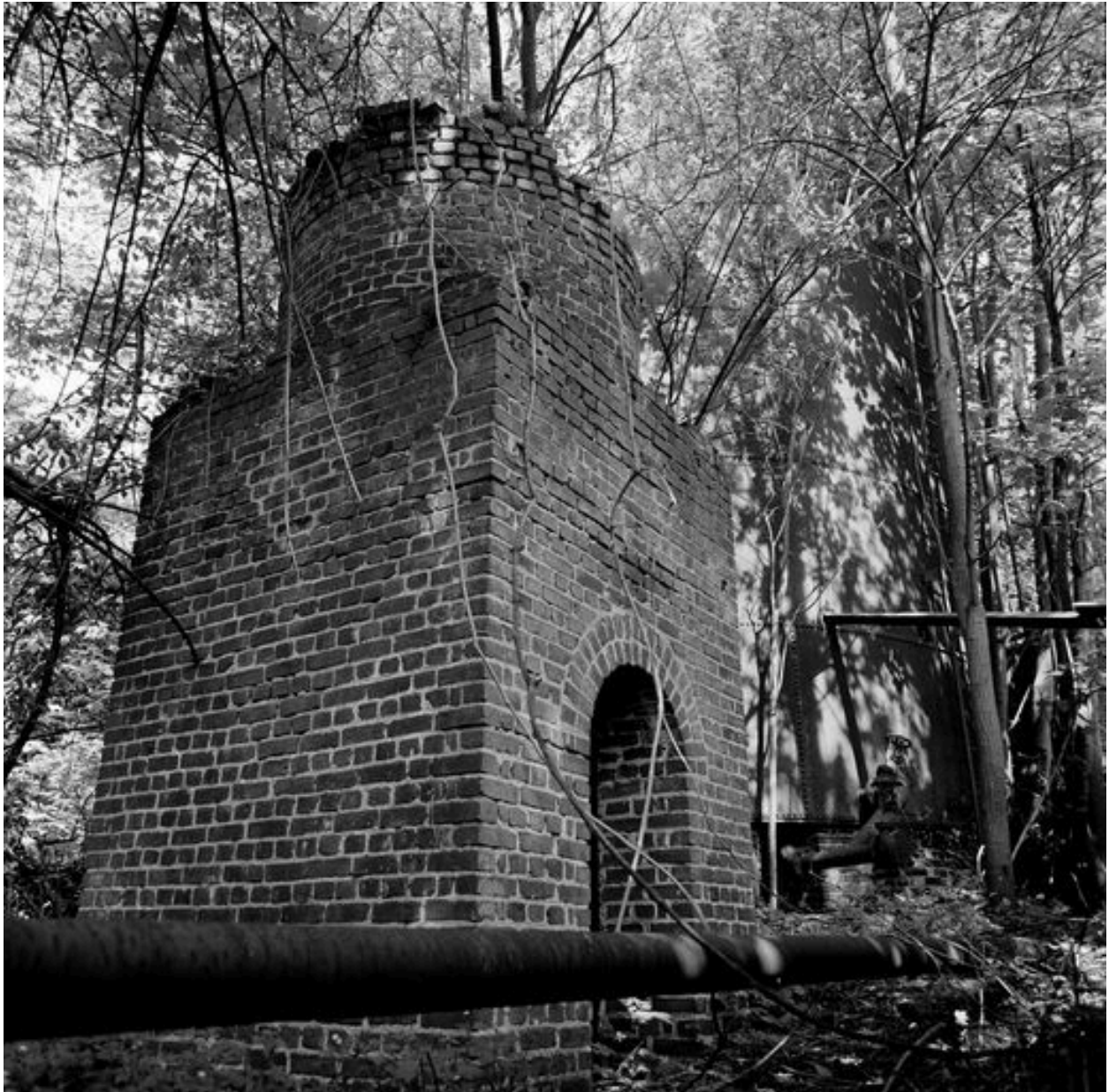
Cheminée d'usine : socle.
