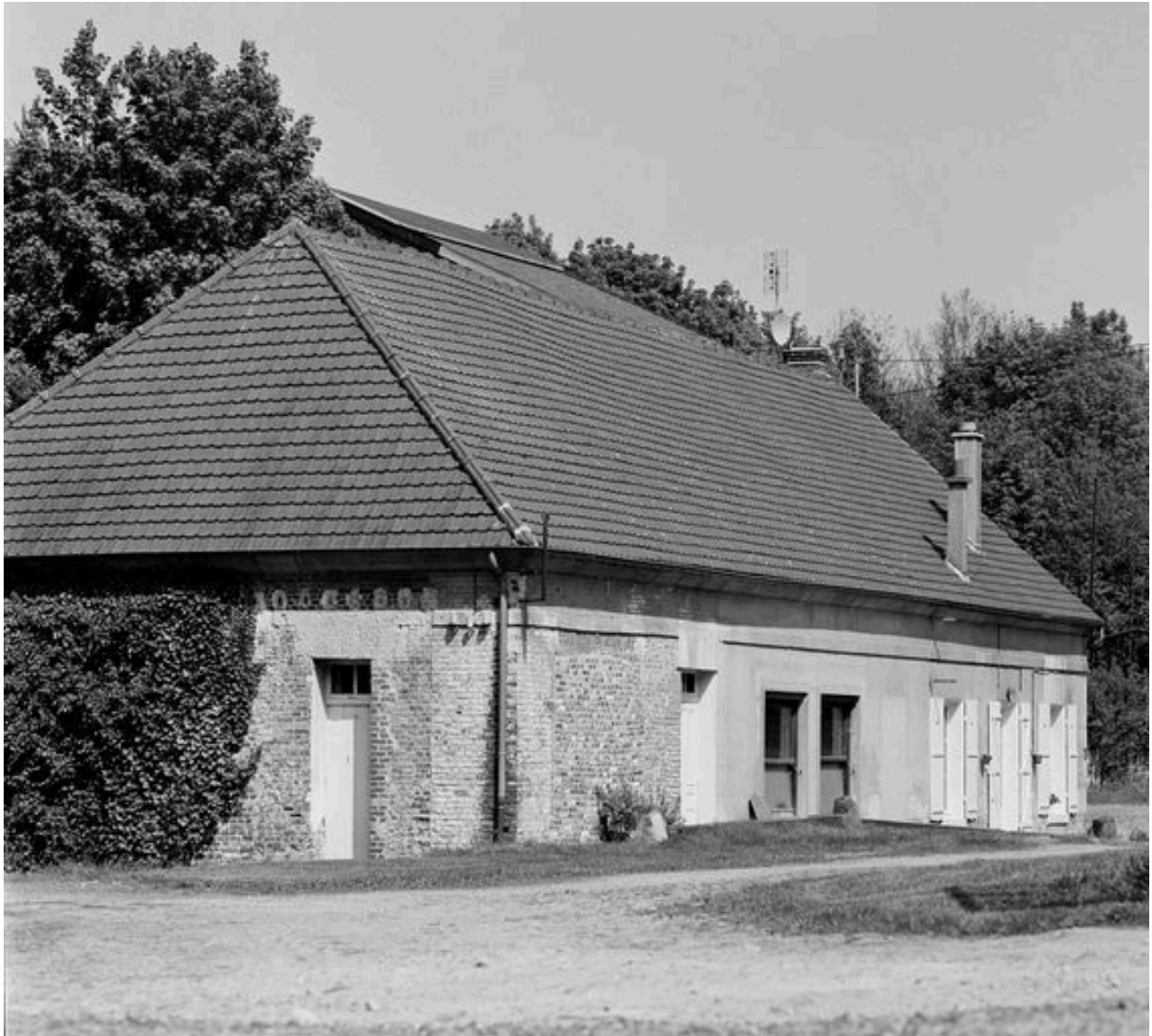
Bureau, façade nord.
