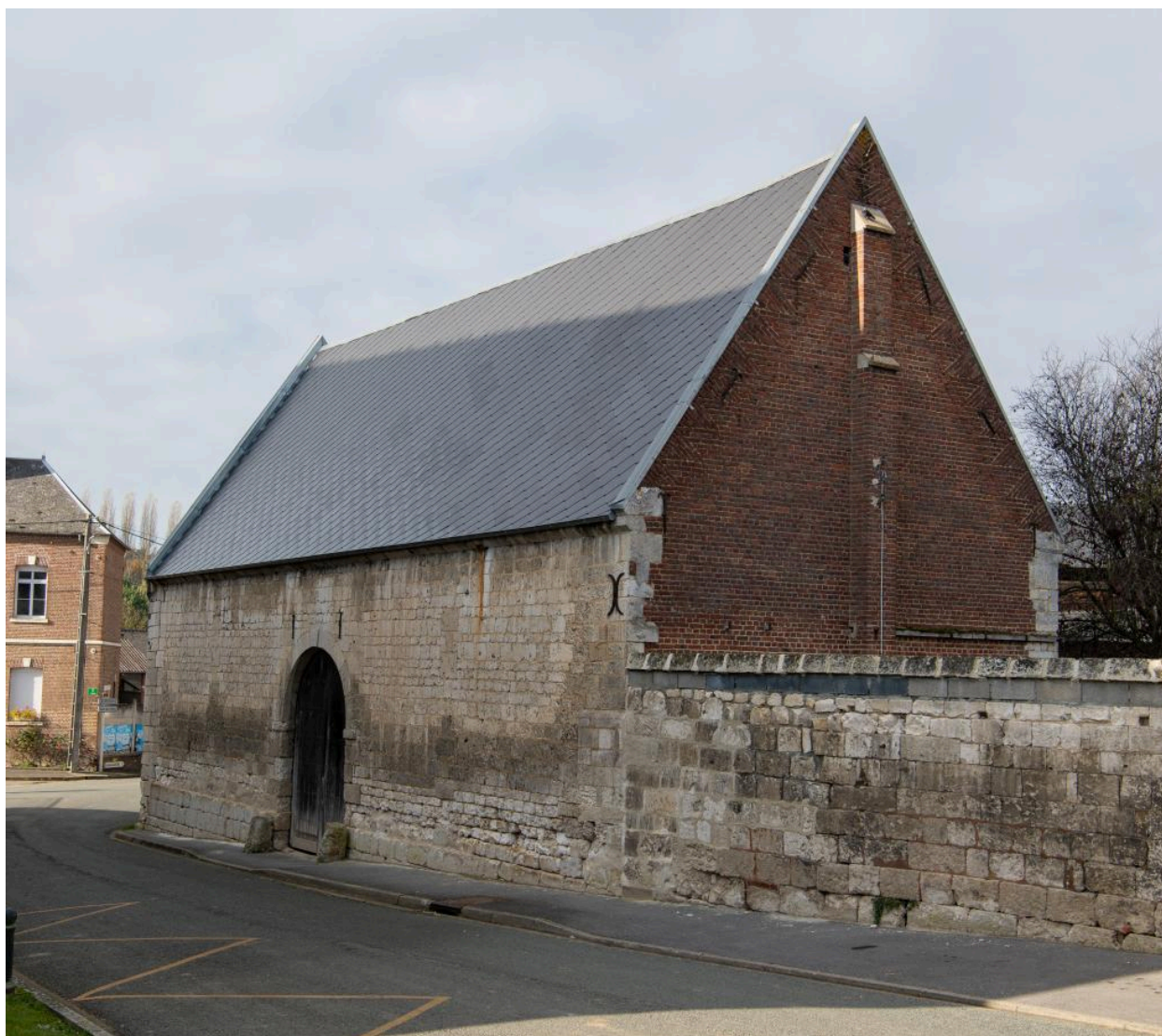
Ancienne grange aux dîmes du chapitre cathédral d'Amiens, n°2 rue de l'Église, vue depuis l'est.
