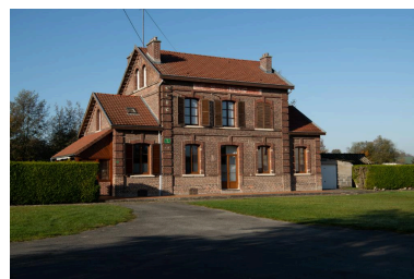
Façade de l'ancienne gare, n°1 place de la Gare, vue depuis le sud-est. Phot. Marc Kérignard IVR32_20216001333NUCA
