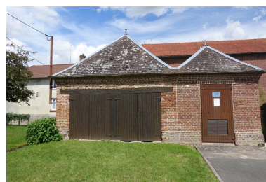
Bâtiment de remise des pompes à incendie, années 1860, vue depuis l'ouest. Phot. Lucile Chamignon IVR32_20216005101NUCA
