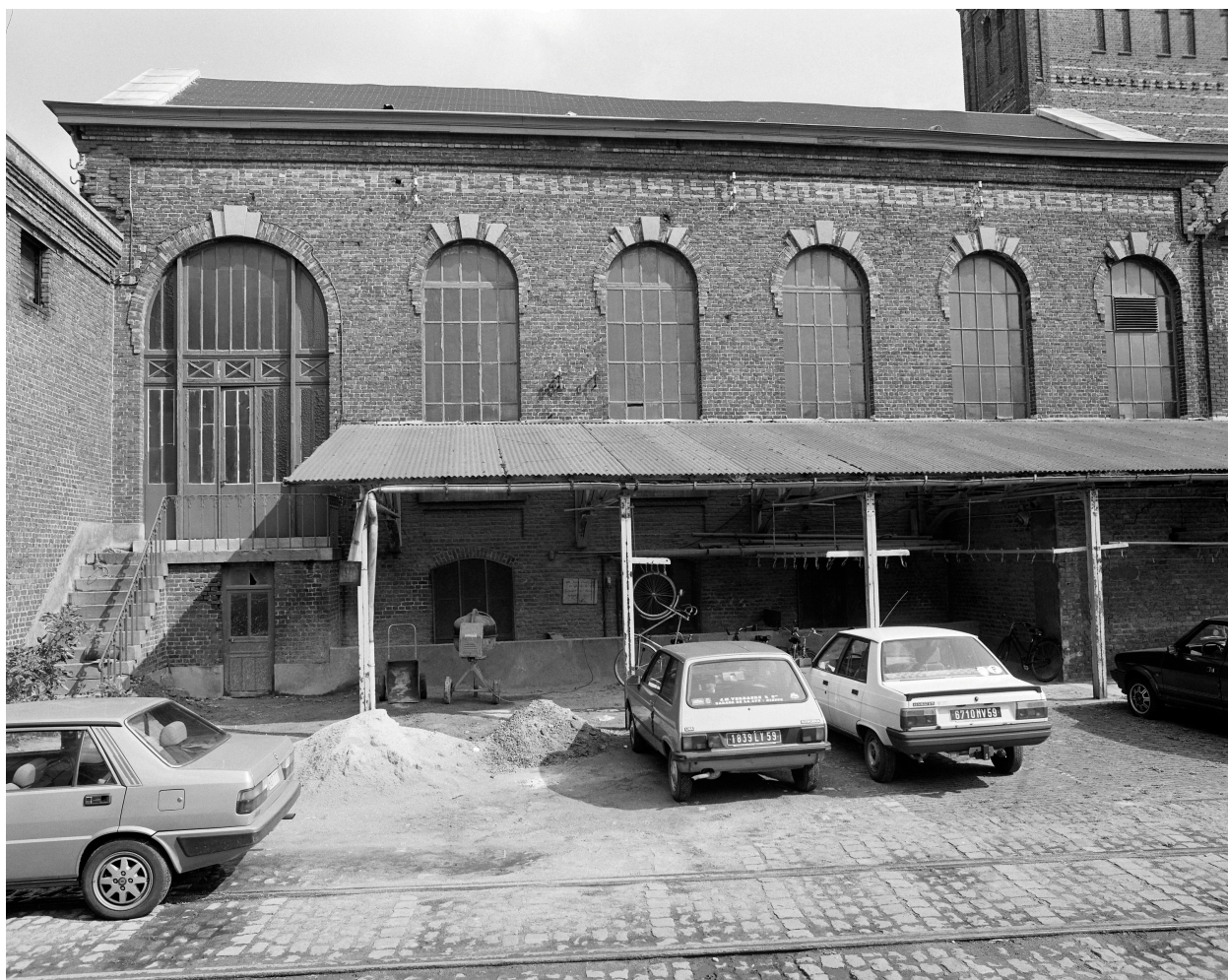
Salle des machines. Élévation sur cour.
