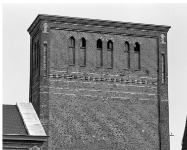
Chaufferie, détail du château d'eau. Phot. Philippe Dapvril IVR31_19885901858X
