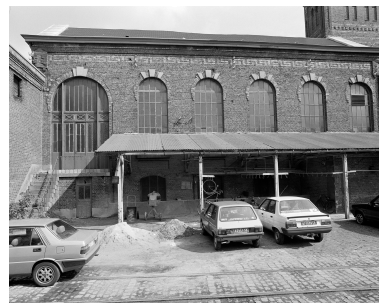
Salle des machines. Élévation sur cour. Phot. Philippe Dapvril IVR31_19885901861X
