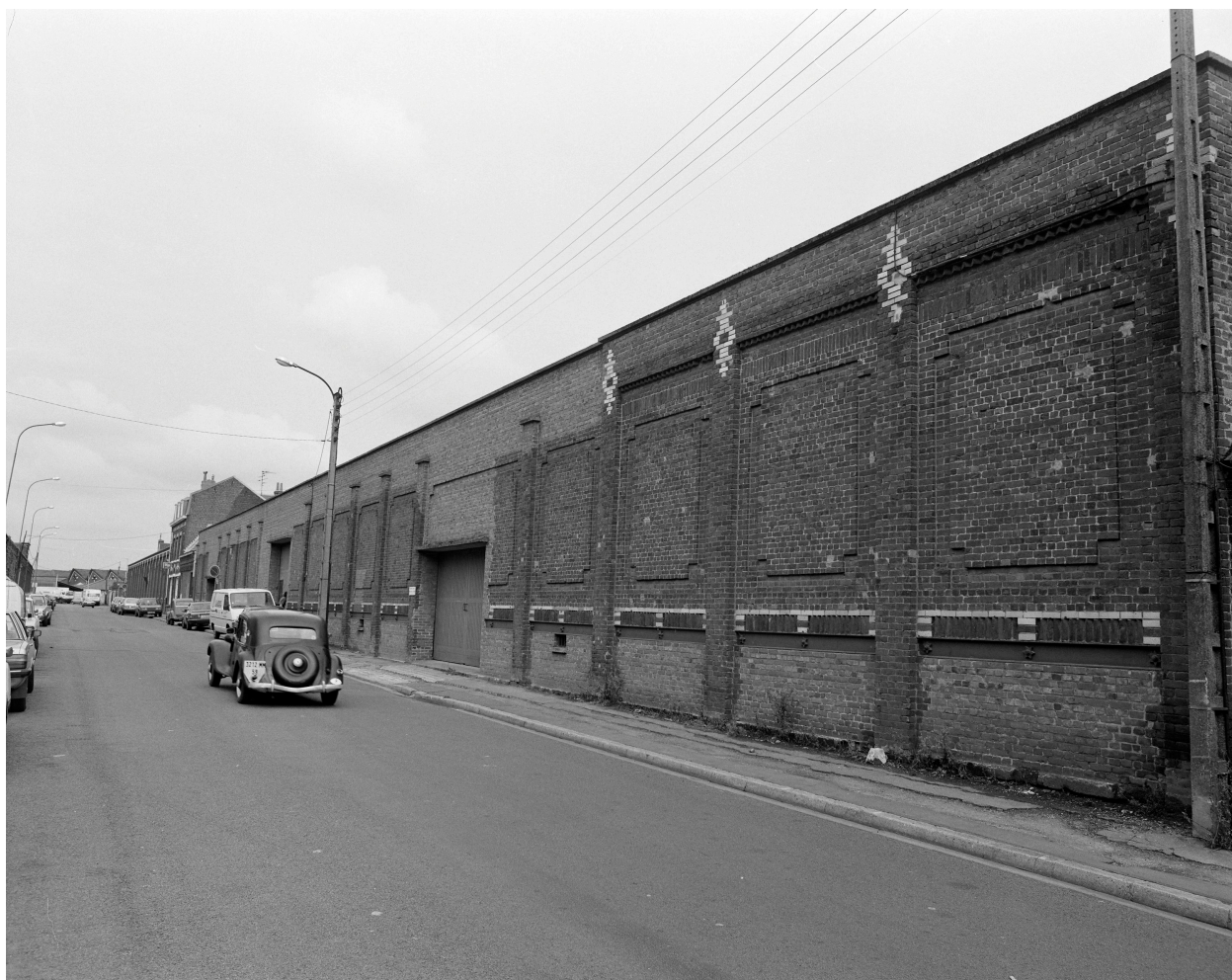
La filature, rue Pierre-Brossolette, vers le nord-est.
