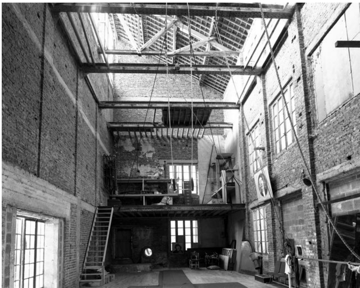
Elévation intérieure de la minoterie, transformée en salle d'entraînement.
