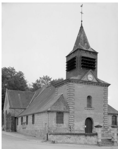
Elévation occidentale. Phot. Jean-Michel Perrin IVR22_19846001208V
