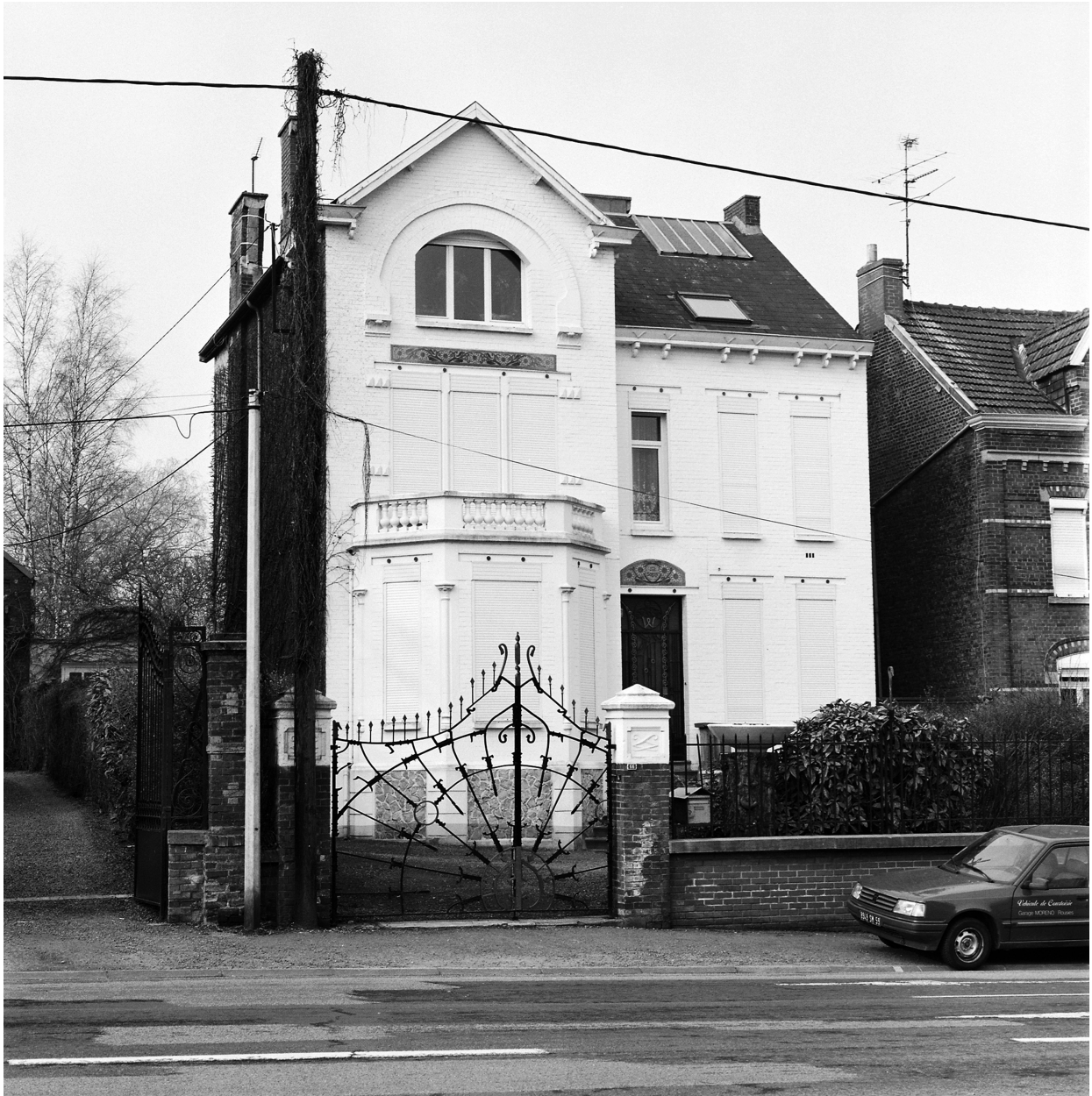
Vue générale de l'élévation antérieure.
