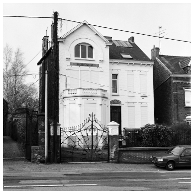
Vue générale de l'élévation antérieure. Phot. Thierry Petitberghien IVR31_20035900285X
