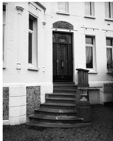
Entrée de la maison : le perron, la porte en feronnerie et le décor de mosaïque portant la signature. Phot. Thierry Petitberghien IVR31_20025900370X
