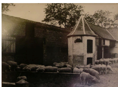
Vue dans les années 1960 du pigeonnier aujourd'hui détruit ainsi que des greniers au fond de la cour en torchis et pans de bois, désormais remplacés par de la tôle.
