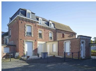
Maison - 50, place du Général-Leclerc : façade arrière. La maçonnerie de brique est cantonnée aux chambranles des baies et à la corniche sous la toiture.
