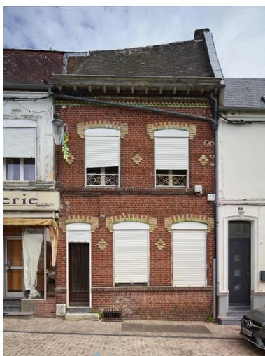
Maison à boutique - 18, rue du Maréchal-Joffre : les décors de maçonnerie en brique sont cantonnés aux arcs des baies. La brique émaillée est utilisée pour les arcs des baies, des calepinages géométriques dans les trumeaux et en frise de dents d'engrenage sous le chéneau.
