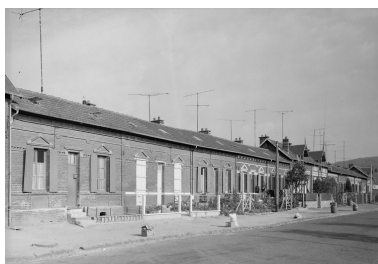
Vue générale. Phot. Fabrice Charrondière IVR22_19856001344X
