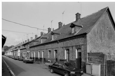
Vue générale, en 1991 : élévations ouest. Phot. Benoît Dufournier IVR22_19918000052Z
