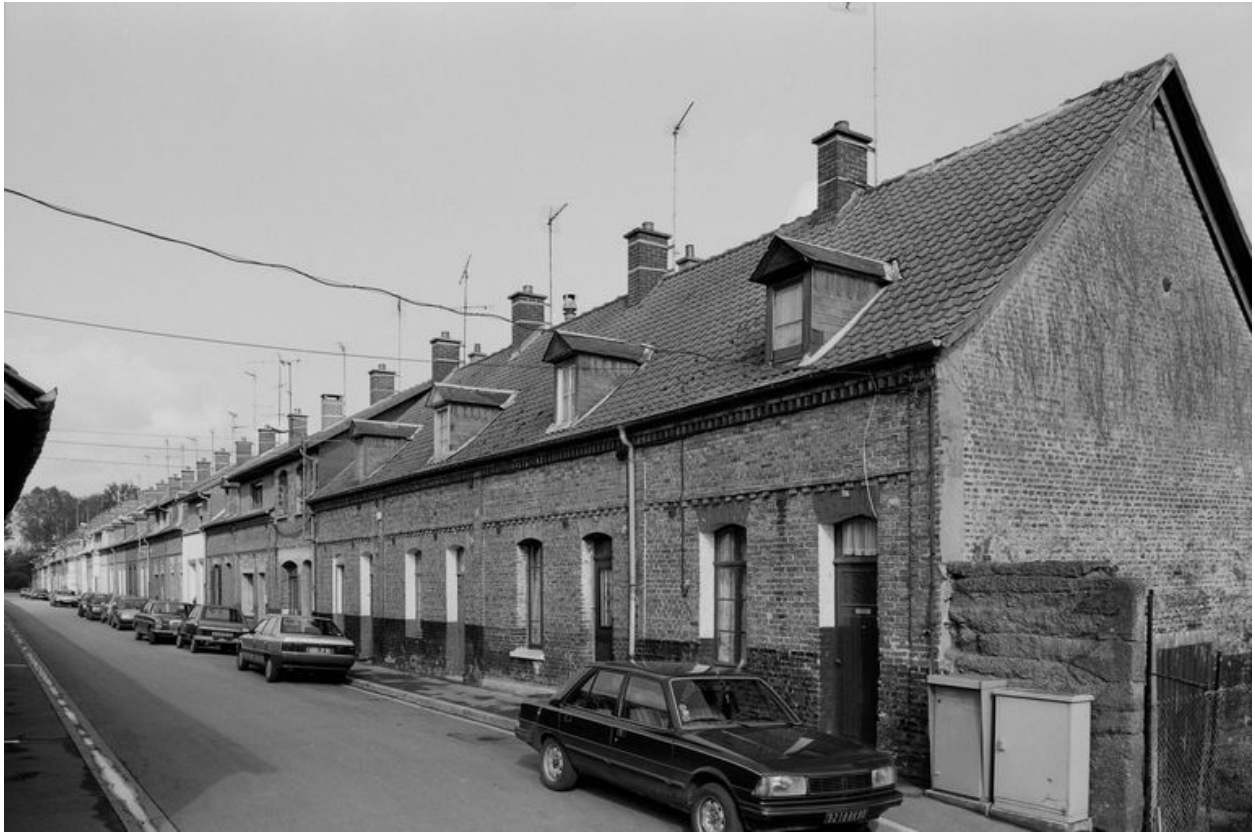
Vue générale, en 1991 : élévations ouest.
