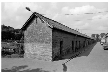
Vue des remises, en 1991. Phot. Benoît Dufournier IVR22_19918000050Z
