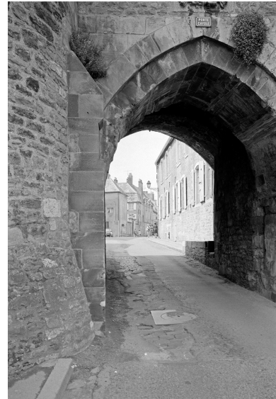
Passage voûté, détail. Phot. Jean-Michel Périn, Phot. Éric Dessert IVR31_19806204016X
