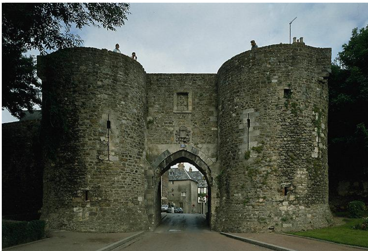
Façade sud sur boulevard.
