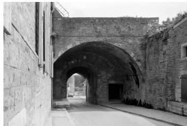
Façade nord, sur rue d'Aumont. Phot. Jean-Michel Périn, Phot. Éric Dessert IVR31_19806203979X
