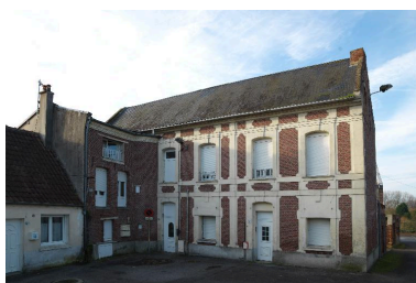
Vue générale, depuis l'est. Phot. Marie-Laure Monnehay-Vulliet IVR22_20158001059NUC2A
