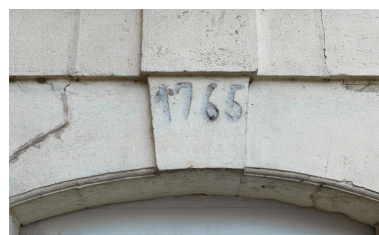
Date gravée sur le linteau. Phot. Marie-Laure Monnehay-Vulliet IVR22_20158001060NUC2A
