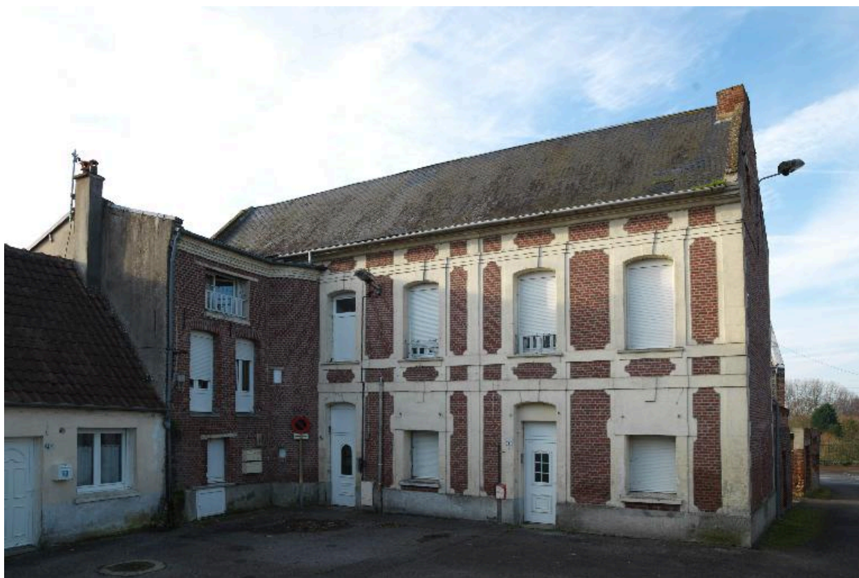
Vue générale, depuis l'est.
