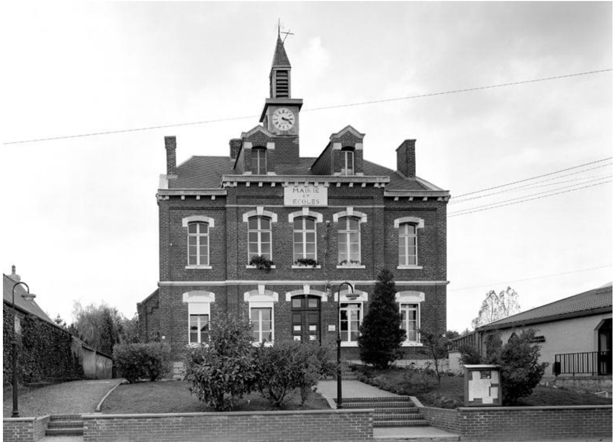
Vue d'ensemble de la façade.
