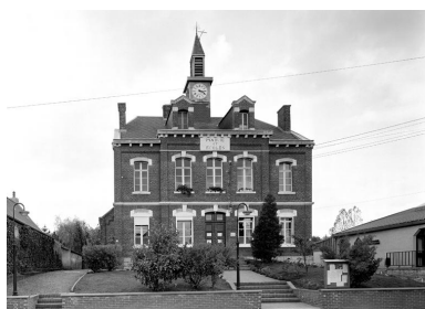
Vue d'ensemble de la façade.
