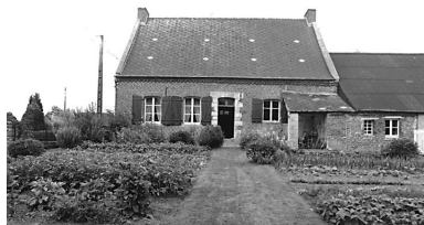
Elévation postérieure du logis, depuis l'est. Phot. Pierre-Yves Brest IVR22_19980202434Z
