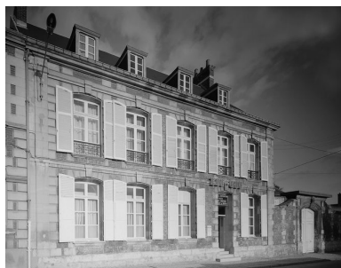
Elévation sur rue. Phot. Fabrice Charrondière IVR22_19856001482V
