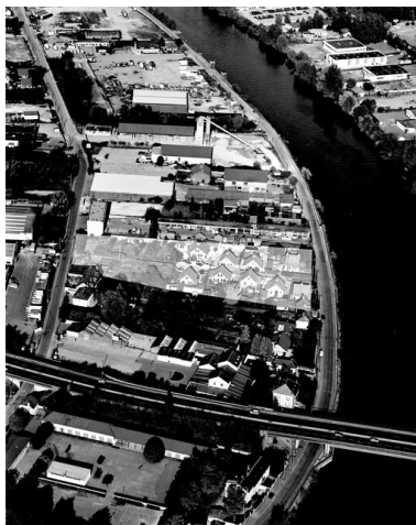
Vue aérienne de la cité de la Tonnellerie et de ses jardins en 1995. Phot. Sanson Aviation IVR22_19956000649X
