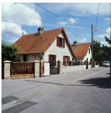
Maisons de la cité ouvrière. Phot. Thierry Lefébure IVR22_20076000038XA
