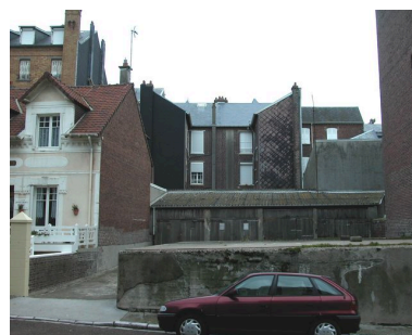
Garages en fond de parcelle (1982 AE 588) et base d'un blockhaus, 15 rue Duquesne. Phot. Elisabeth Justome IVR22_20058003491NUCA
