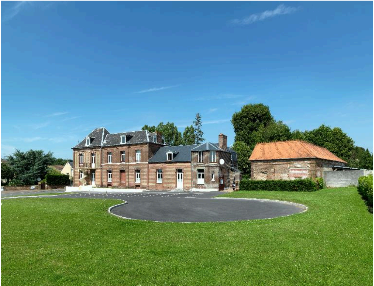
Ancien logement patronnal Caqueret.
