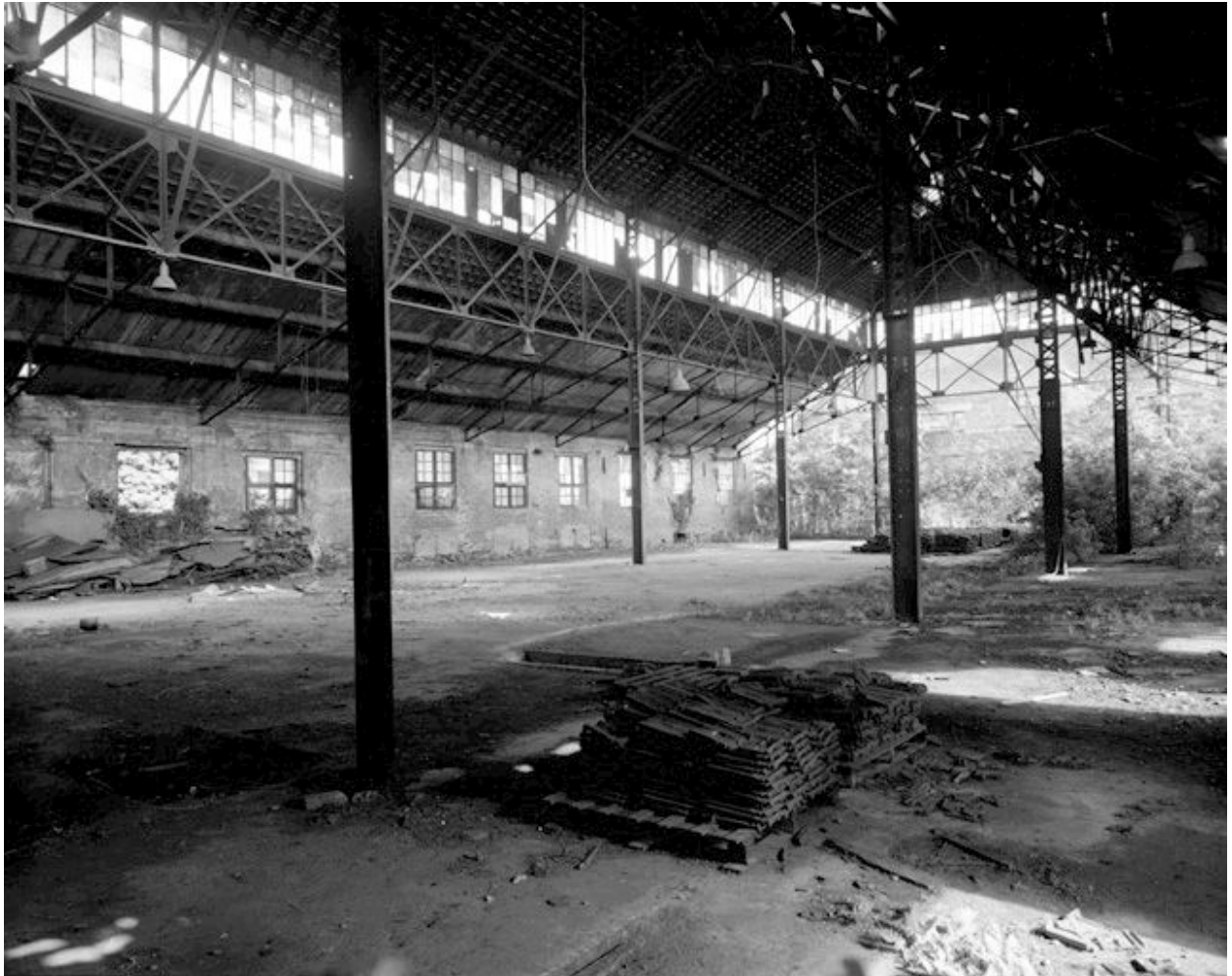
Atelier de fabrication, vue intérieure partielle, en 1988.
