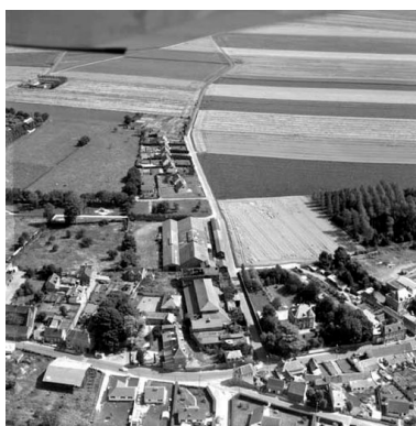
Vue aérienne du site, en 1988. Phot. Phot'R IVR22_19888001458P
