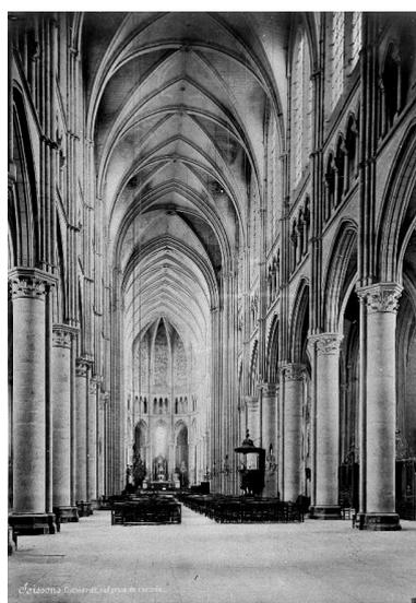
Vue du vaisseau central de la cathédrale, réalisée par Médéric Mieusement vers 1890, et montrant les baies de l'abside sans verrières et obturées par une maçonnerie de brique (AMH Amiens).
