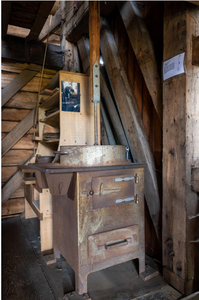
Premier niveau du moulin. Chauffoir.
