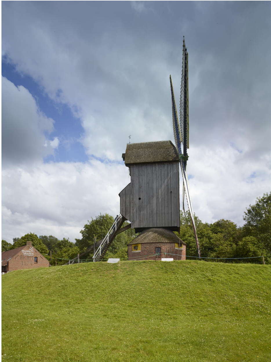
Vue générale prise depuis le nord.
