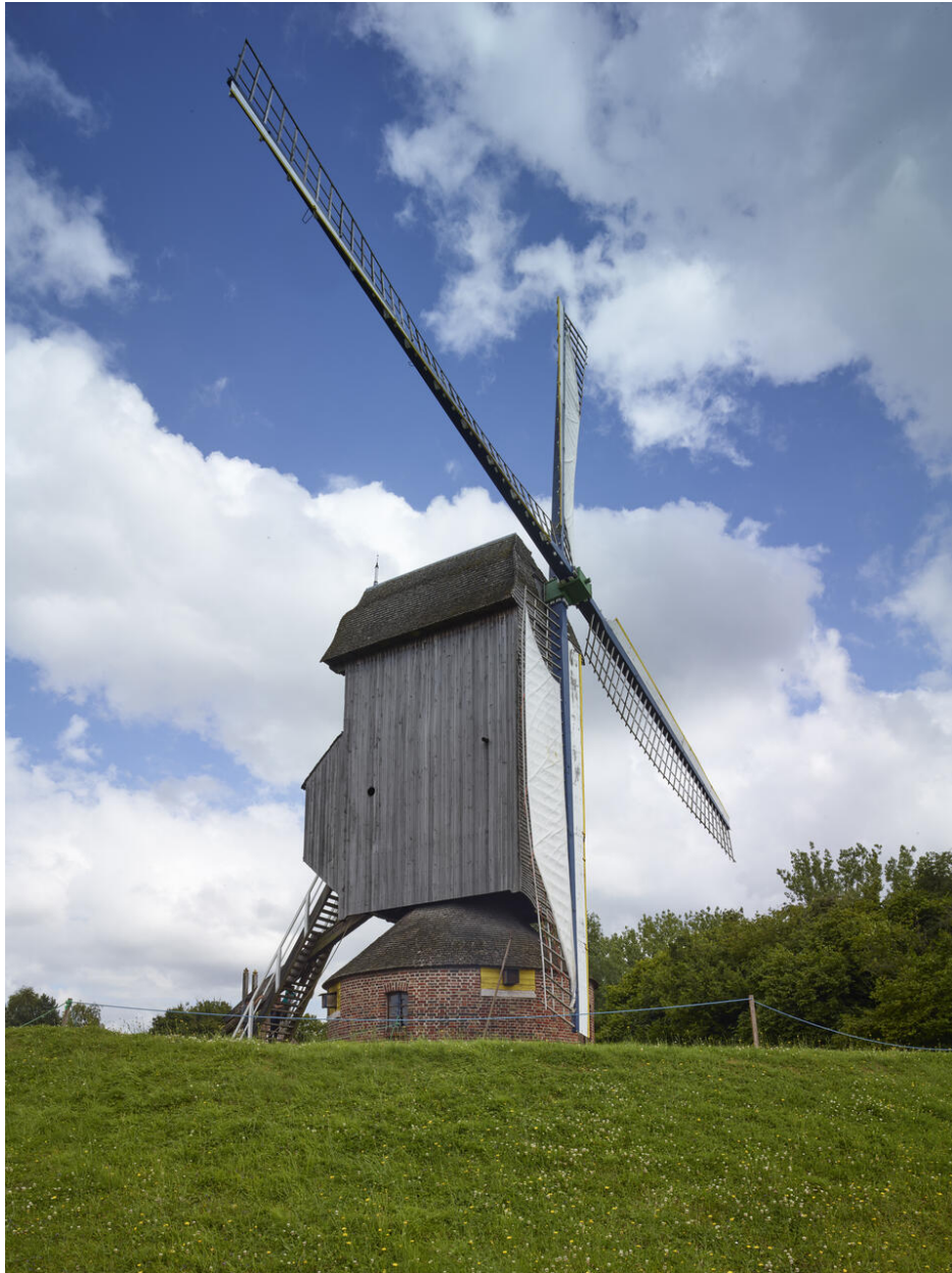
Vue générale prise depuis le nord-ouest.
