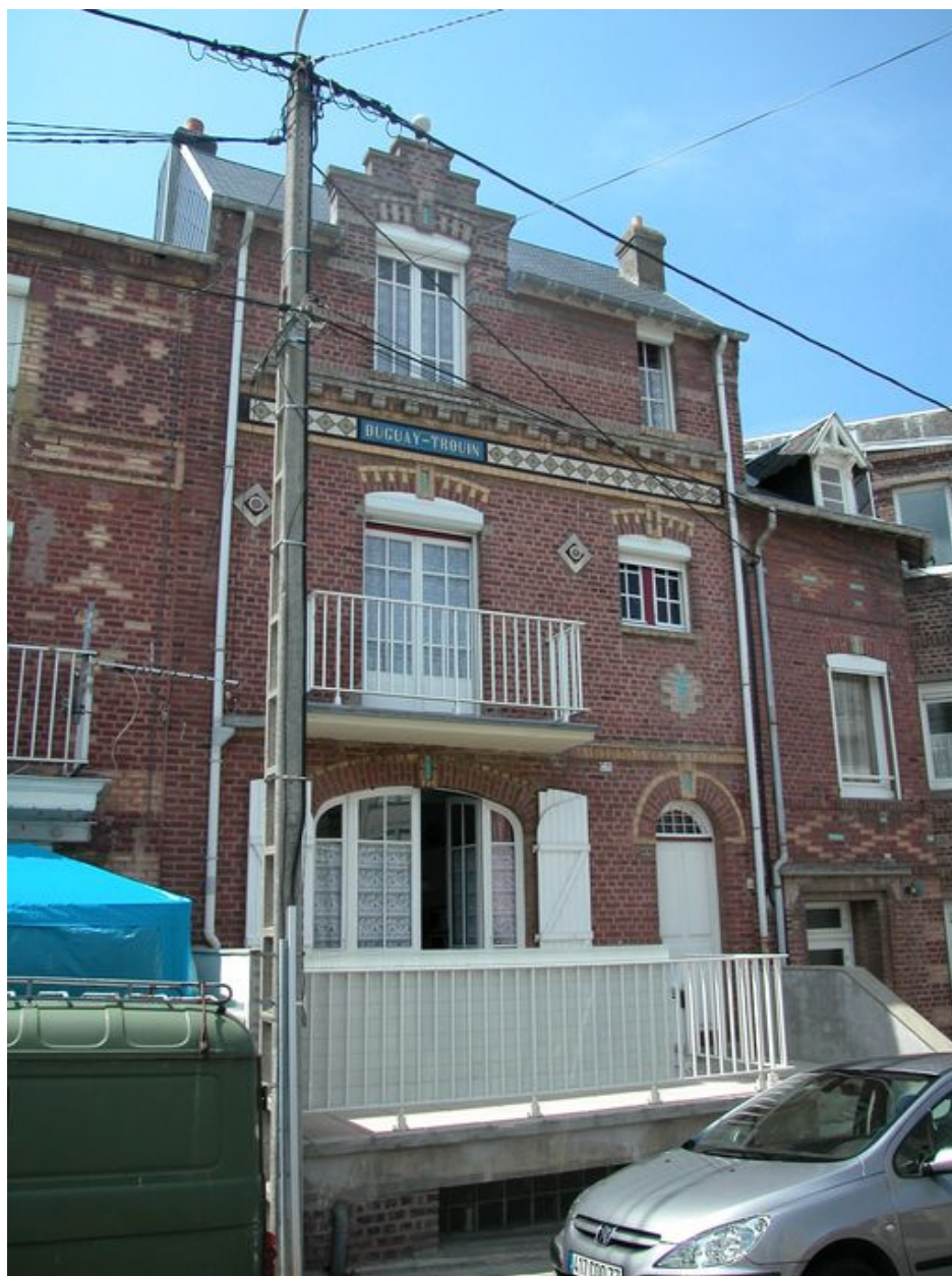
Vue d'ensemble depuis la rue.
