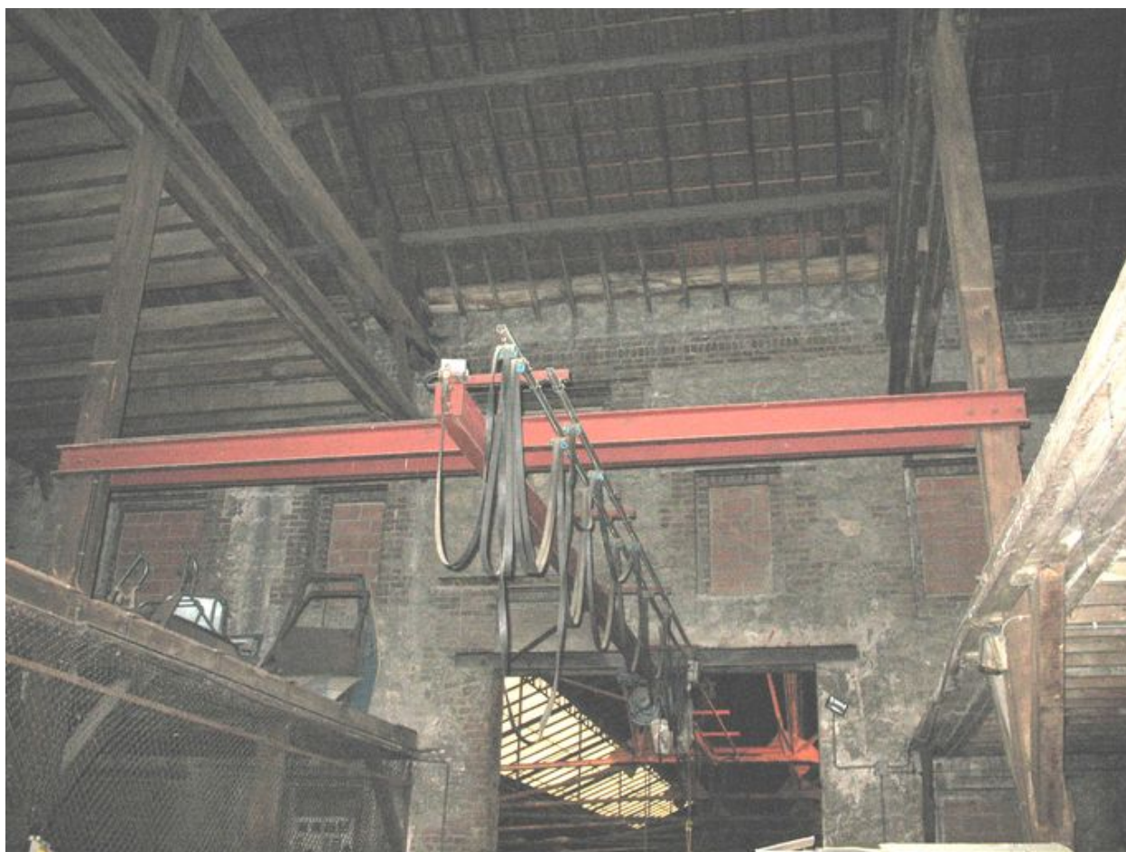
Premier étage de l'ancien relais de chevaux.
