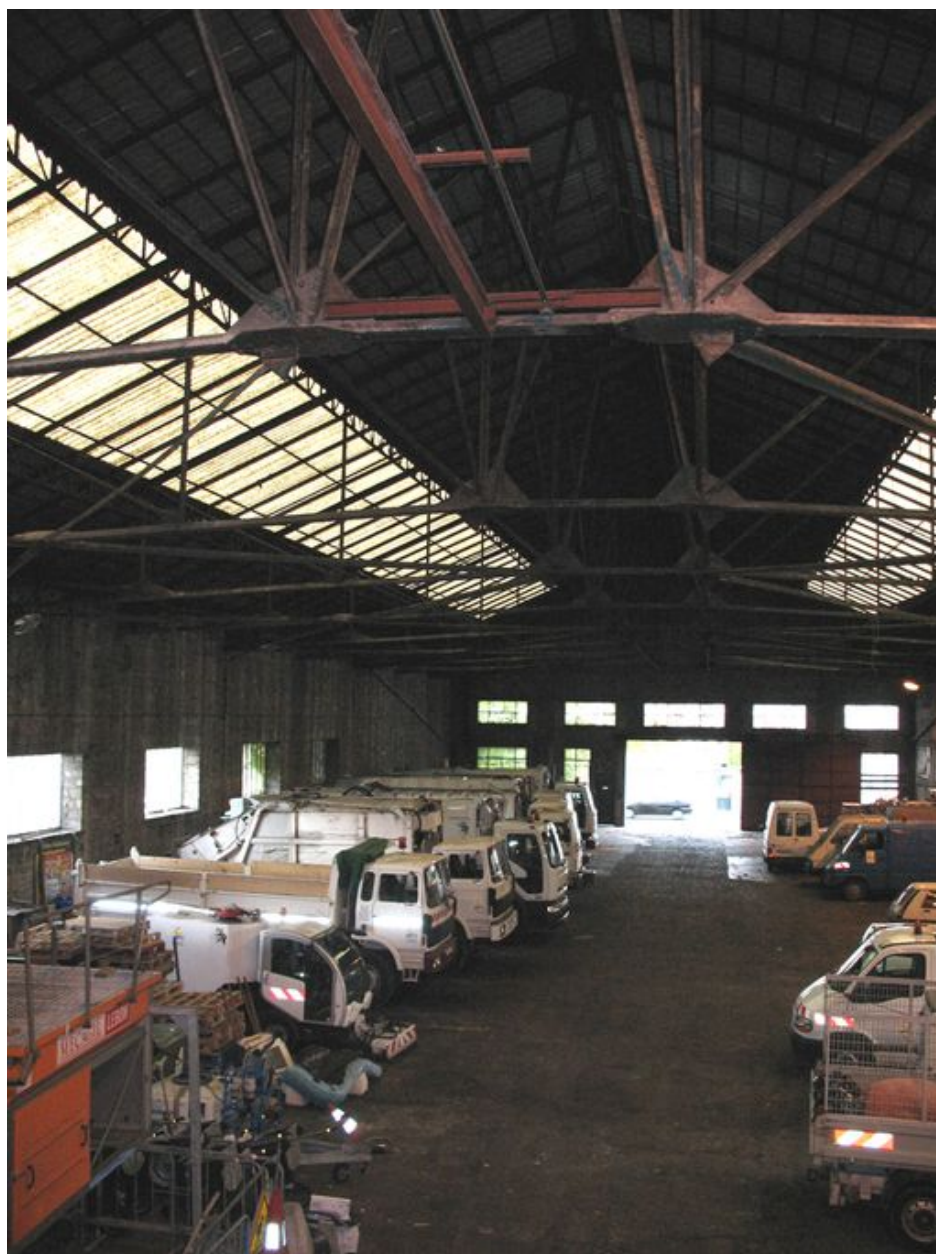
Intérieur des ateliers vu vers le nord.
