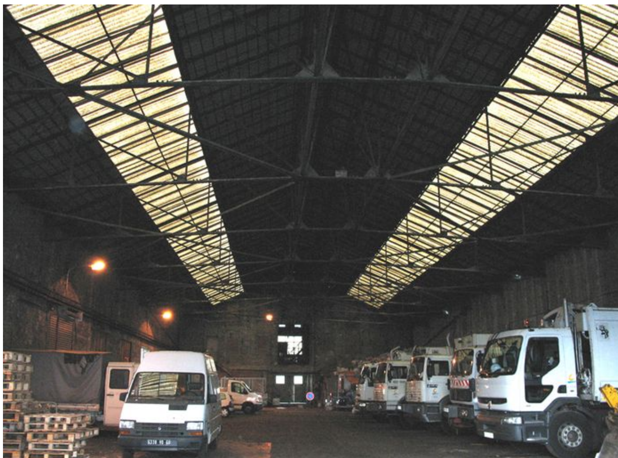
Vue générale de l'intérieur du garage.
