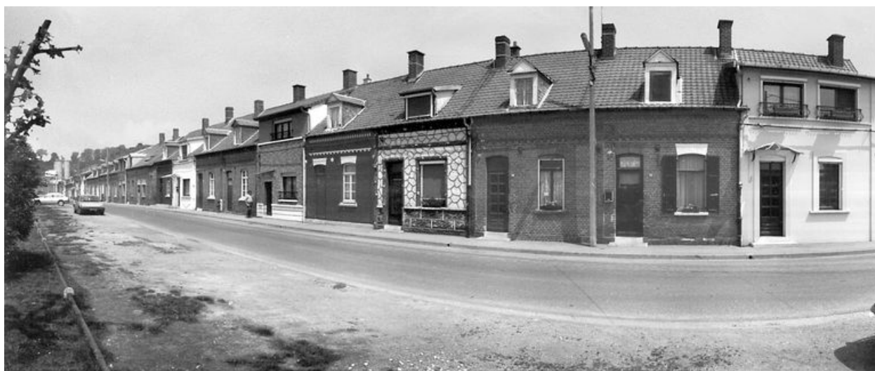
Vue des logements d'ouvriers (rue Marius-Sire), en 1991.
