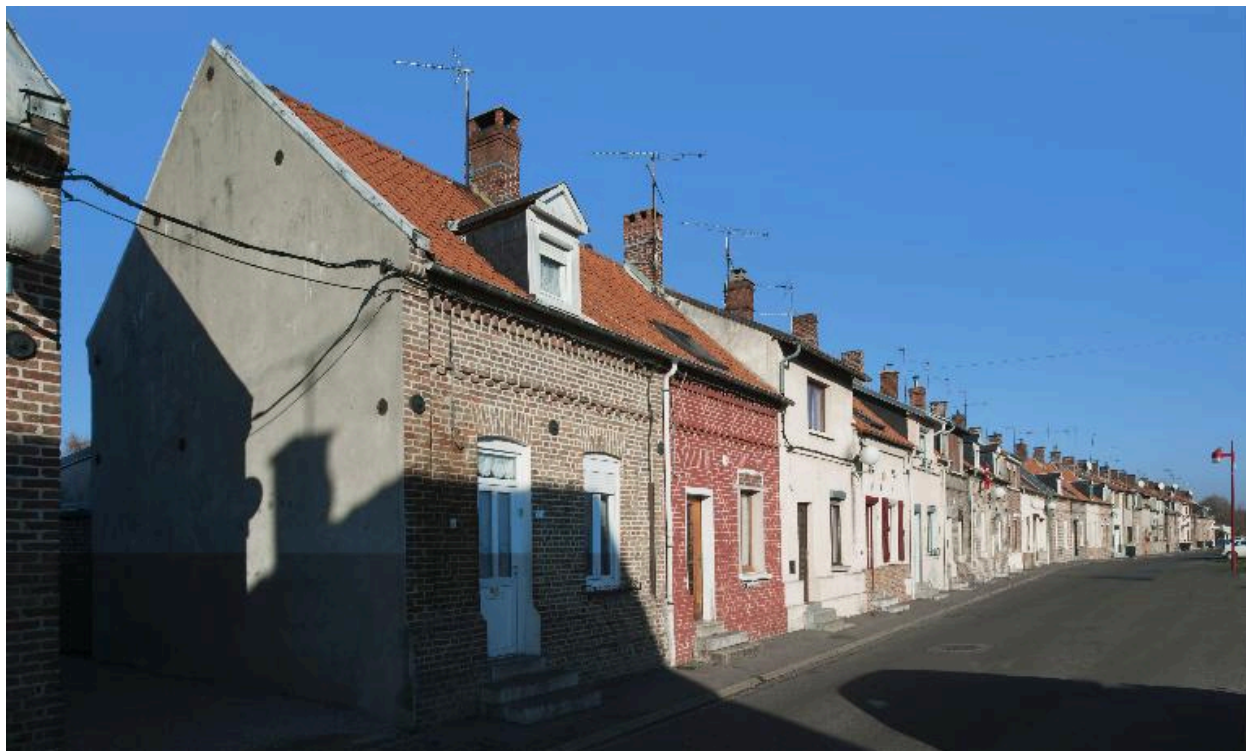
Vue des logements ouvriers, rue Georges-Outrebon.
