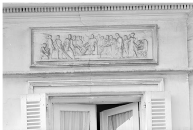
Bas-relief surmontant la travée centrale. Phot. Thierry Lefébure IVR22_19940201196X
