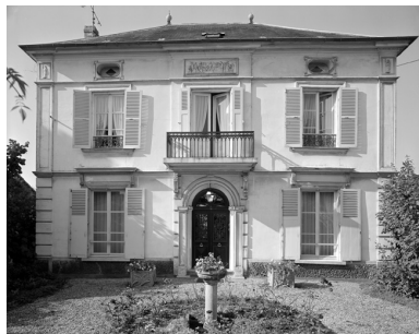
Vue d'ensemble, côté rue. Phot. Thierry Lefébure IVR22_19940201188V
