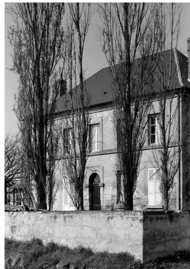
Elévation postérieure. Phot. Jean-Michel Perrin IVR22_19856000573X
