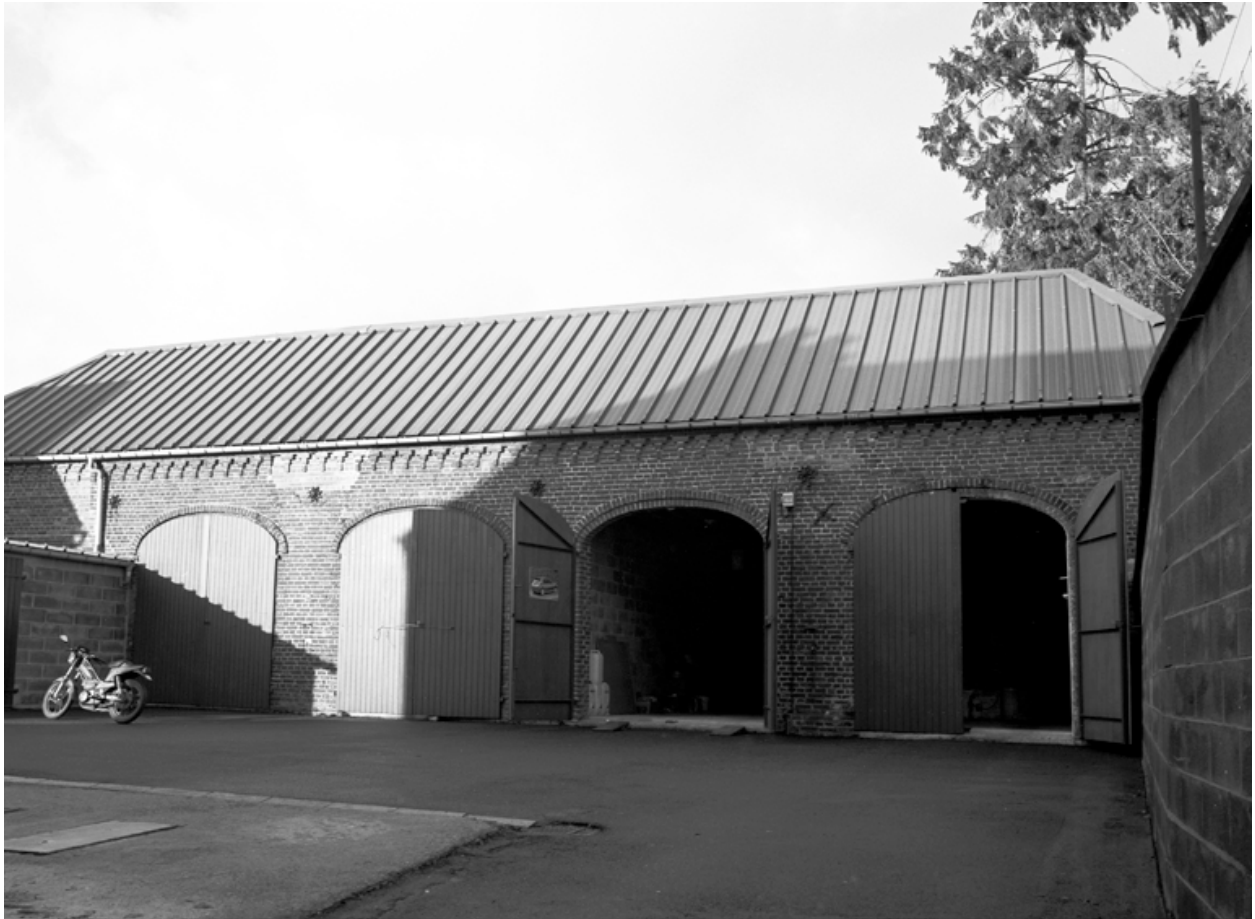
Vue des remises, en fond de cour.
