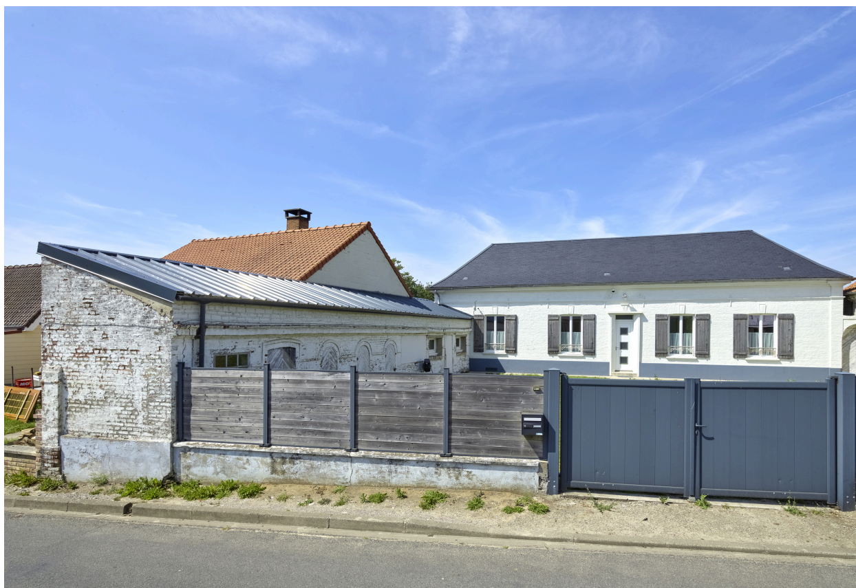
Vue du bâtiment agricole, depuis le sud.
