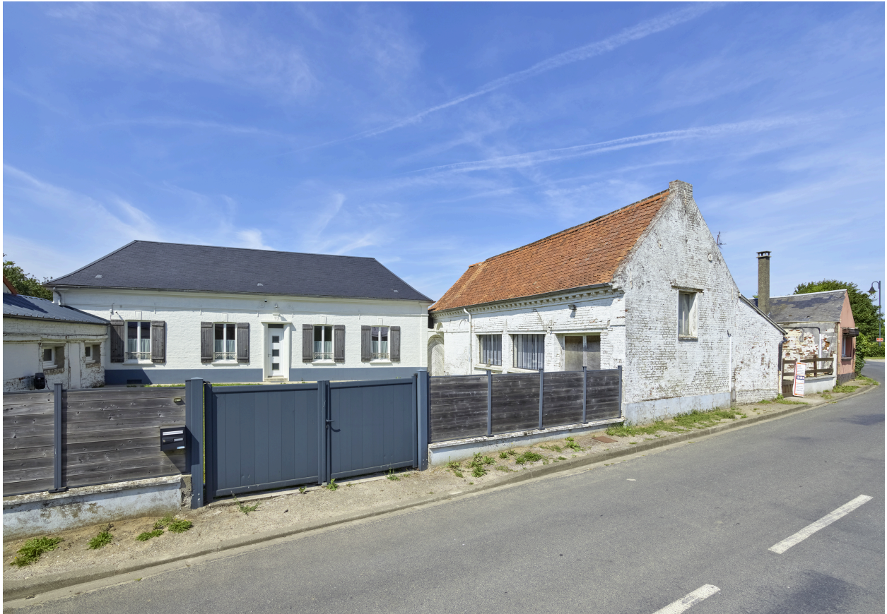
Vue de la boutique de serrurerie, depuis le sud.
