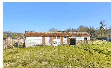
Vue de l'ancien édifice agricole (bergerie ?). Phot. Thierry Lefébure IVR32_20258000119NUCA
