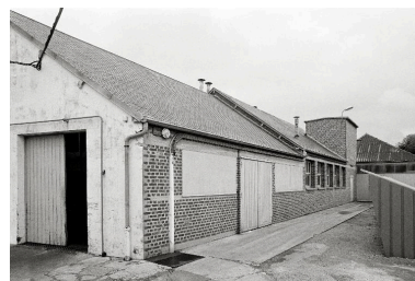
Atelier de fabrication (1946), vue partielle en 1990.
