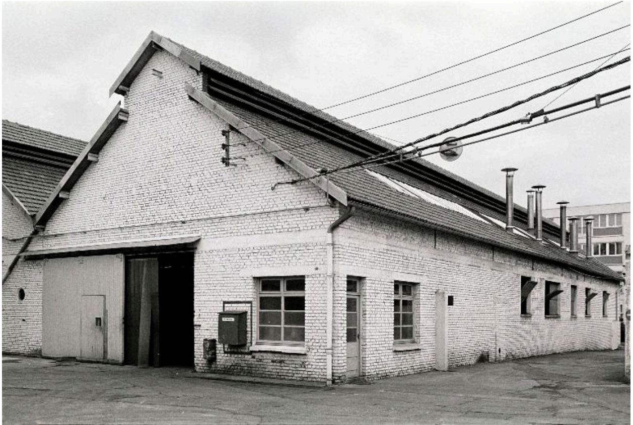
Atelier de fabrication (1960), vue postérieure en 1990.
