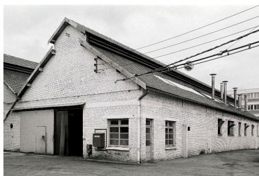
Atelier de fabrication (1960), vue postérieure en 1990.
