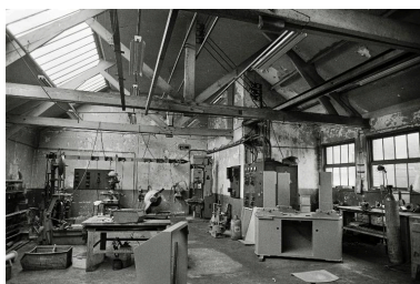
Atelier de fabrication (1946), vue intérieure en 1990.
