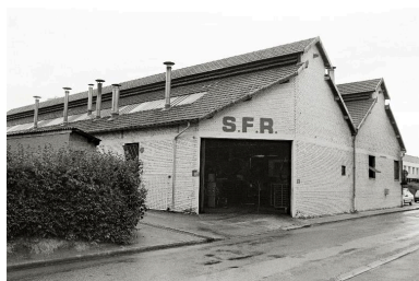
Ateliers de fabrication (1960), élévation antérieure en 1990.
