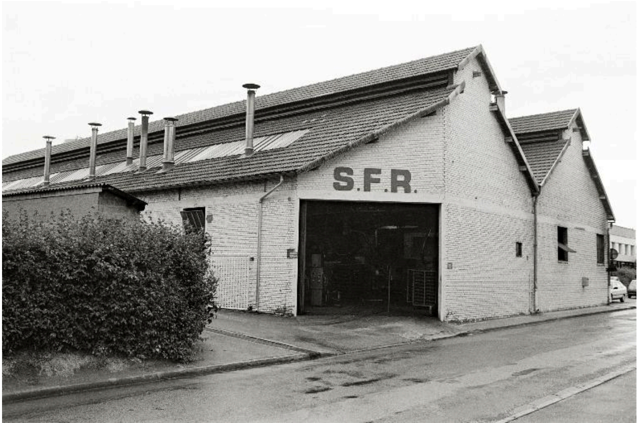
Ateliers de fabrication (1960), élévation antérieure en 1990.
