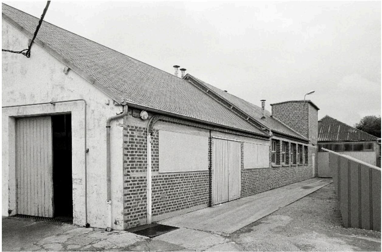
Atelier de fabrication (1946), vue partielle en 1990.
