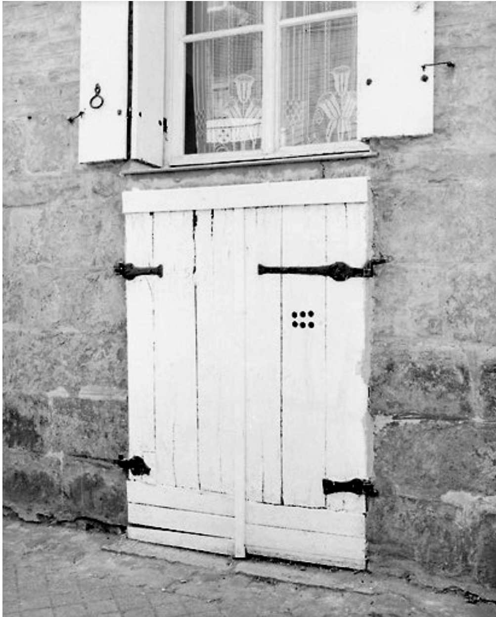
Façade rue Sainte-Barbe, détail : burguet ; état en 2001.
