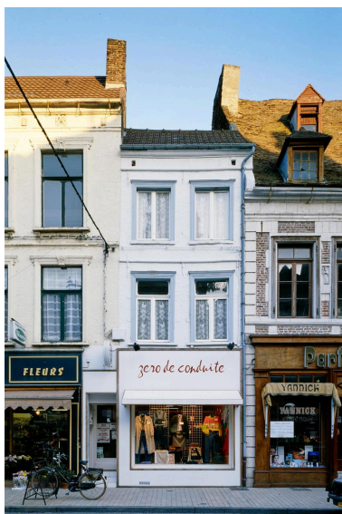
Vue générale de la façade en front de rue. Phot. Philippe Dapvril IVR31_19886200058XA
