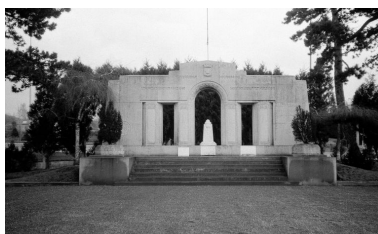
Vue générale. Phot. Christiane Riboulleau IVR22_19968000182Z
