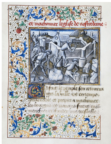
Construction des murs. B. Arsenal, manuscrit. Repro. Philippe Dapvril IVR31_19896200170XA
