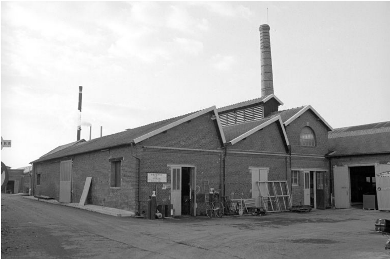
Atelier de fabrication, vue partielle.
