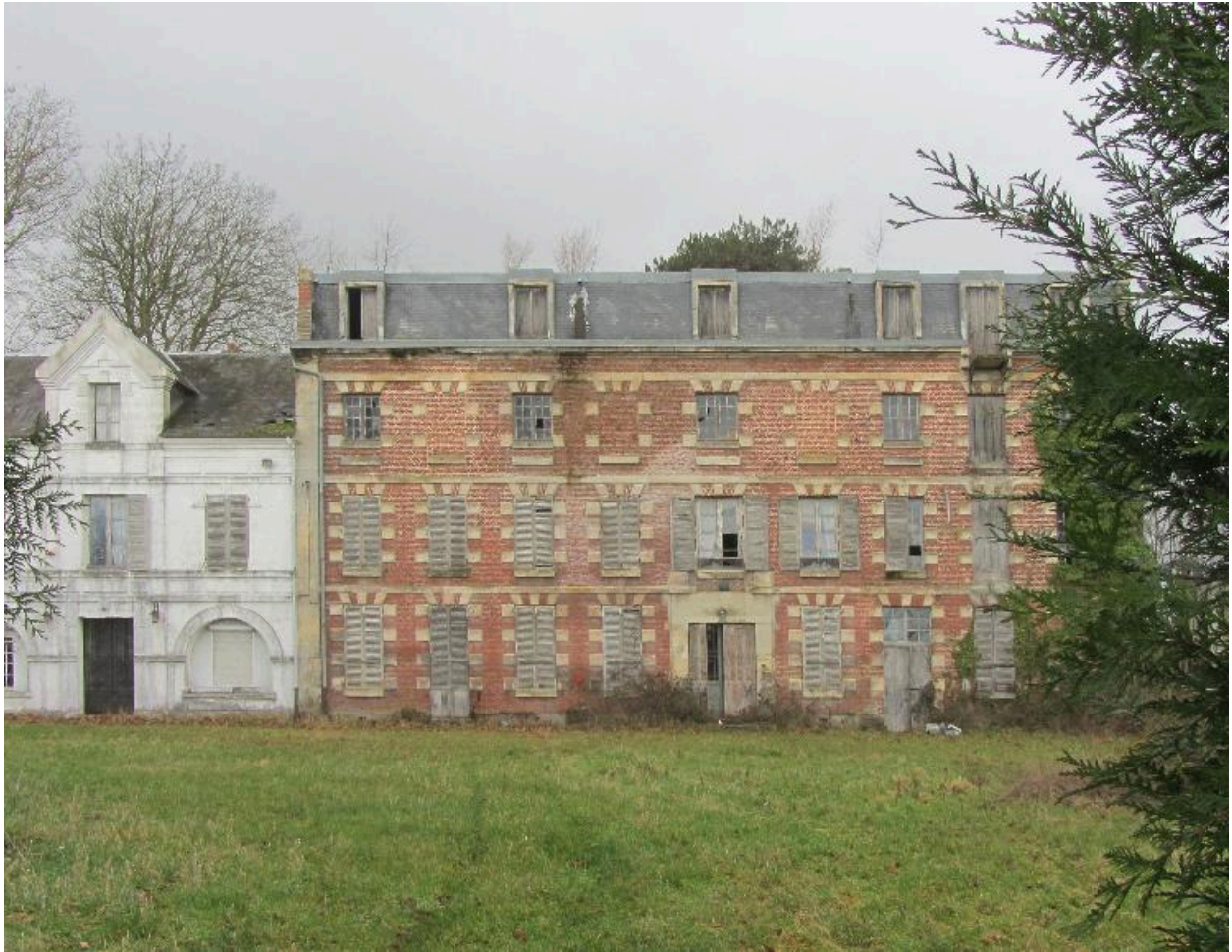
Ancien logement patronal de l'usine Lefrant.
