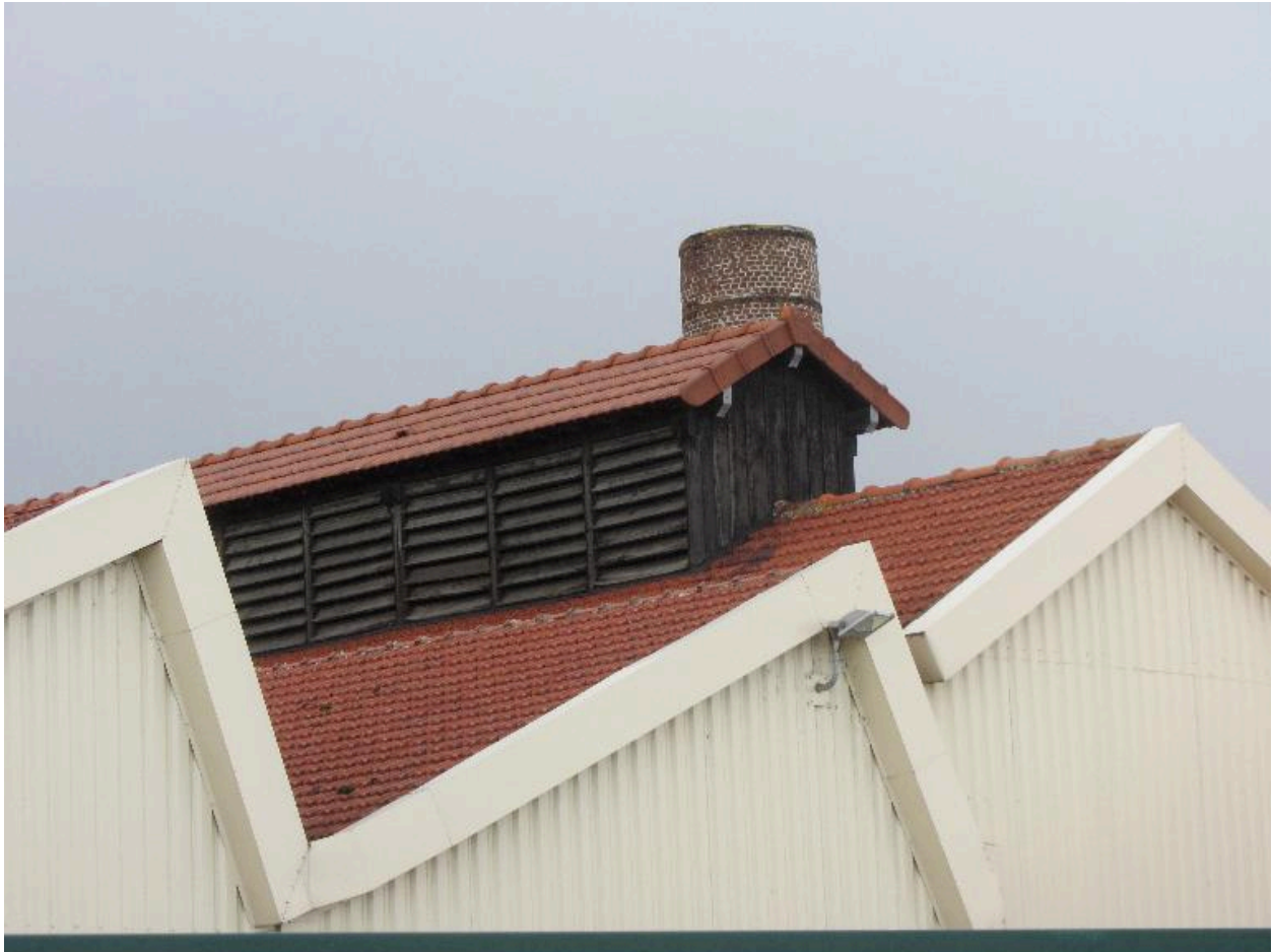
Détail de la couverture en shed et des events d'aération.
