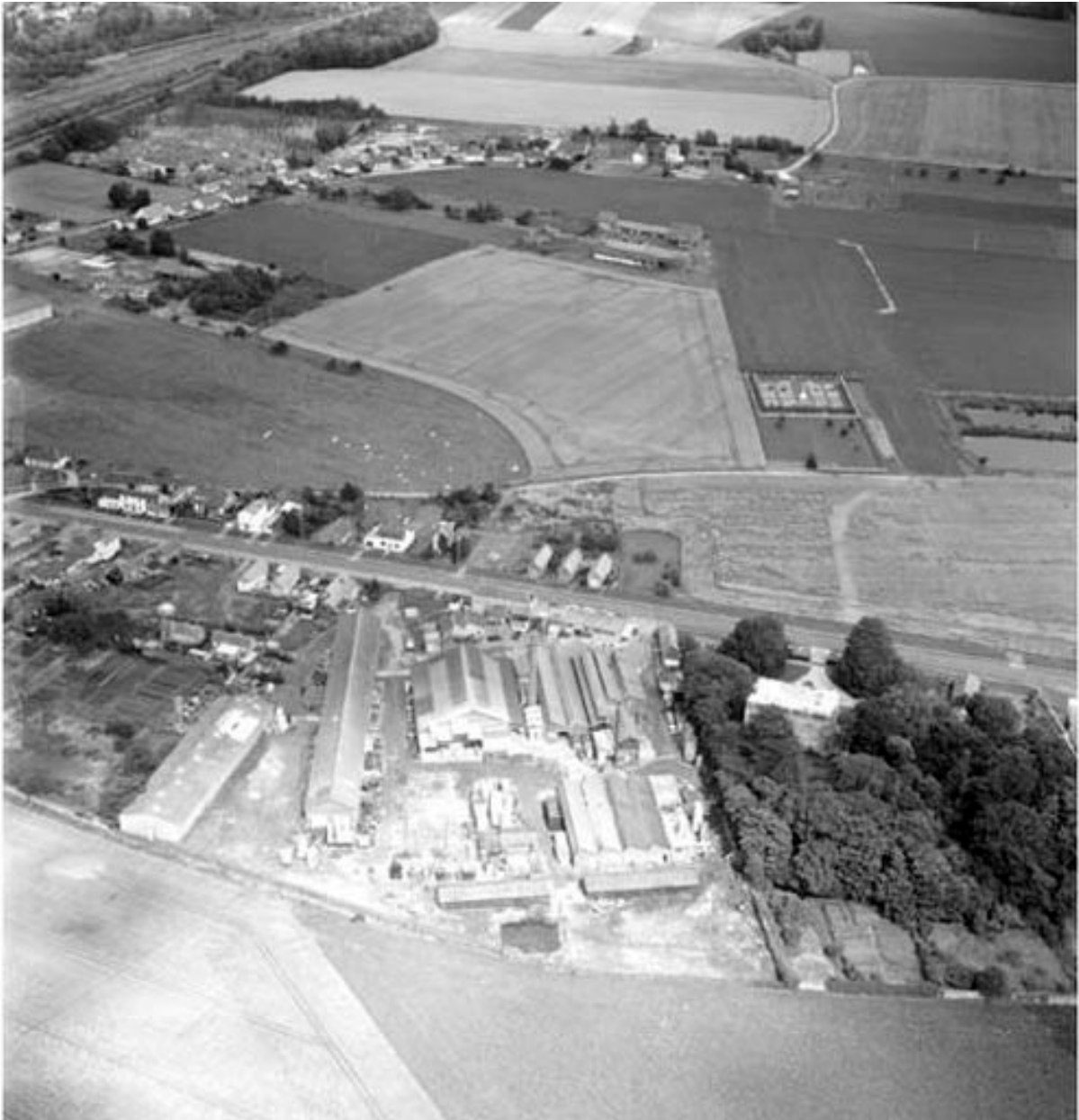
Vue aérienne, flanc sud-ouest.
