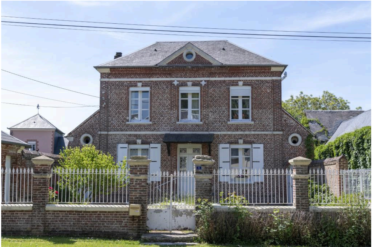
Ancien presbytère, n°1 rue Gaillard, vue de la façade depuis la rue.
