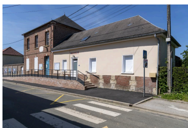
Mairie-école, n°4 rue Léger, vue de la façade sur rue. Phot. Marc Kérignard IVR32_20216000589NUCA
