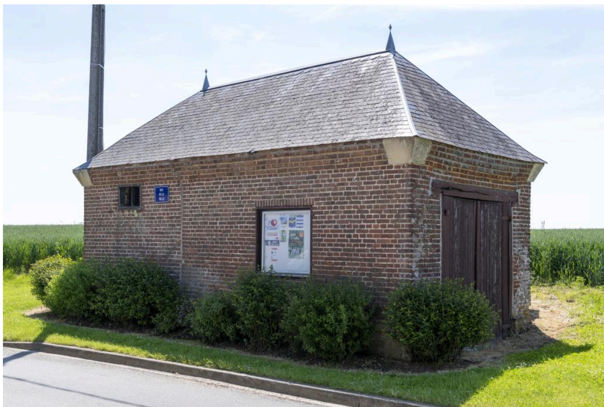
Remise des pompes à incendie, construite entre 1855 et 1870, rue de la Ville, vue depuis le nord-ouest.
