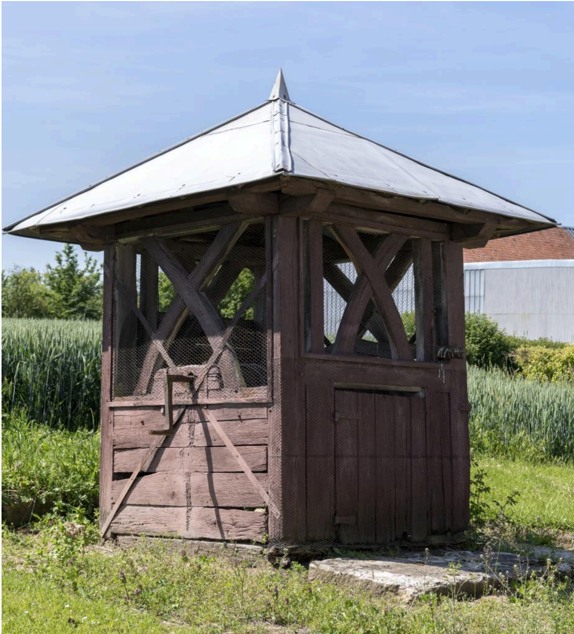
Puits avec abri en bois, rue de la Ville, vue depuis le nord-est.
