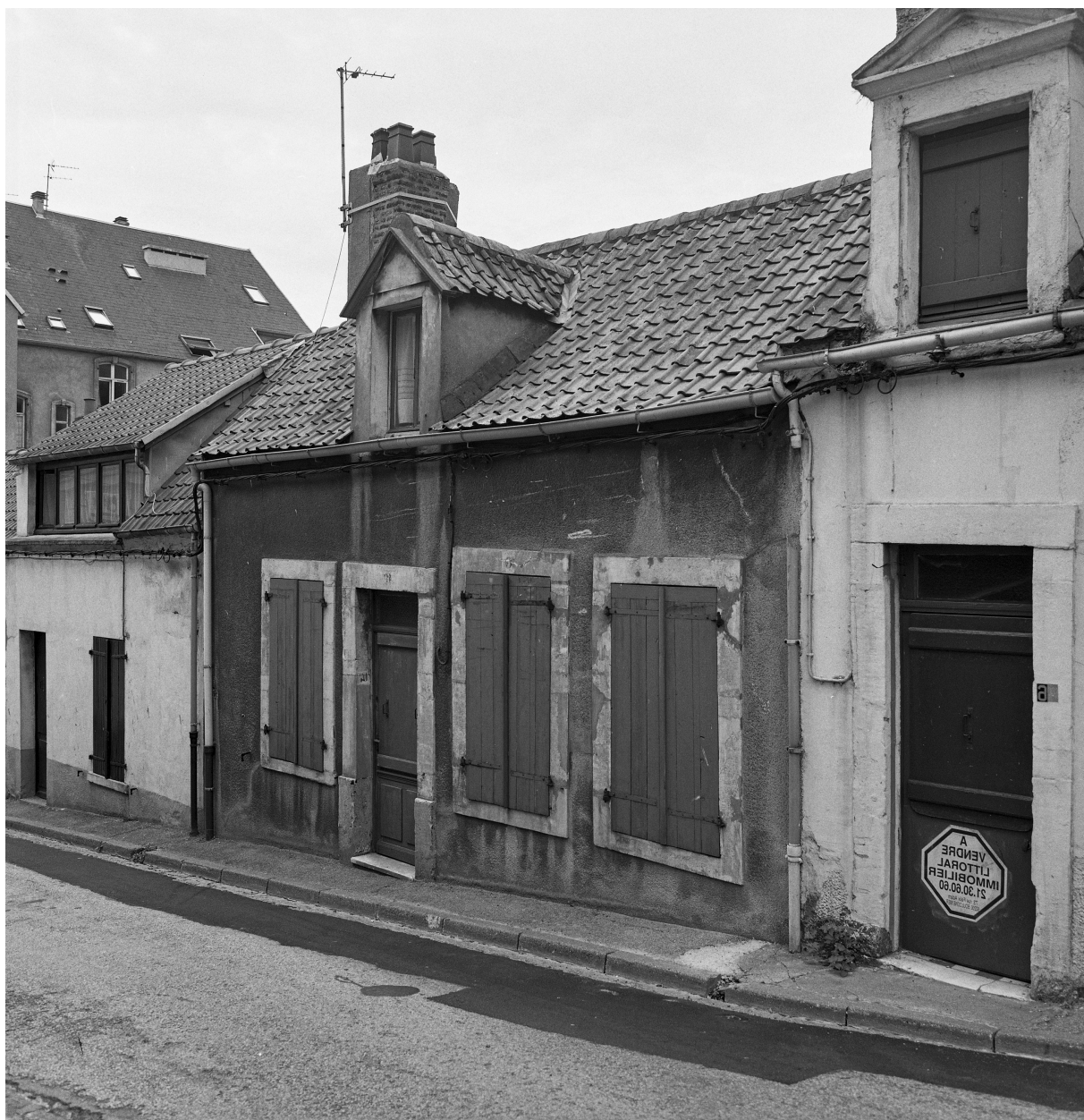
Vue d'angle sur voie.
