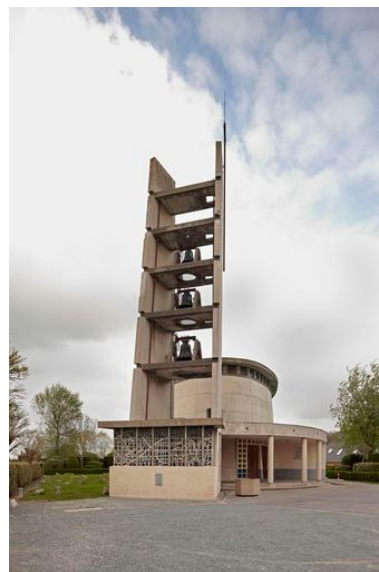
Vue du clocher. Phot. Hubert Bouvet IVR31_20106200716NUCA
