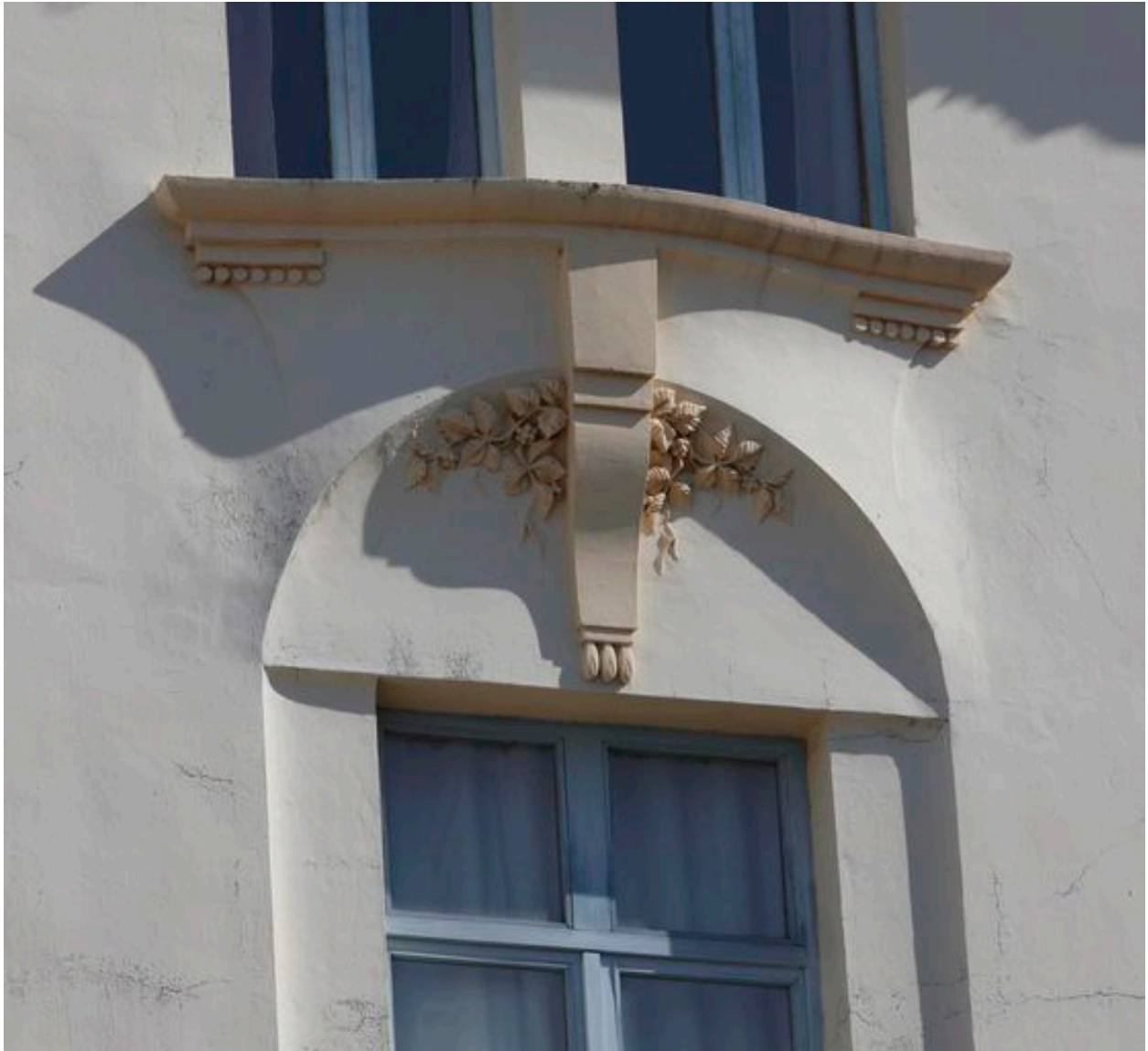
Console géométrique et ornementation florale des linteaux.
