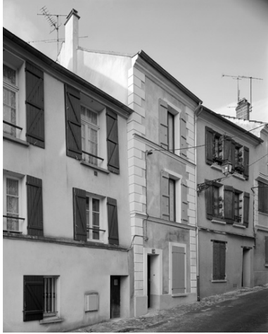
Vue générale depuis la rue. Phot. Thierry Lefébure IVR22_19940201135V
