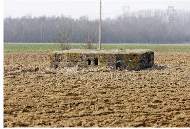
Vue vers le nord. Phot. Jean-Marc Ramette IVR31_20145904046NUCA
