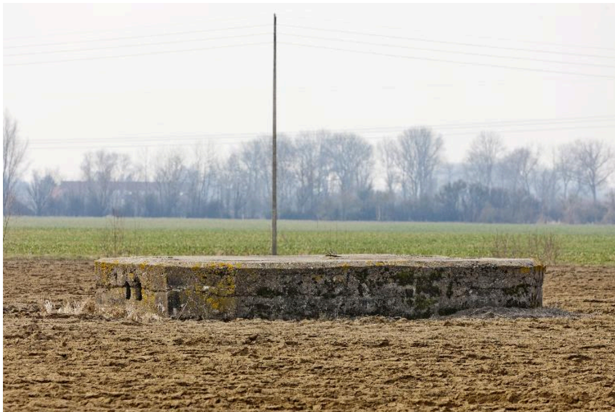
Vue vers l'ouest, depuis la route des Ansereuilles
