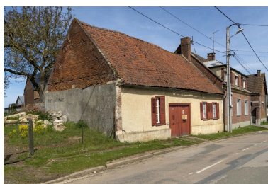
Ancienne maison de serger (?), n°62 rue Principale, vue depuis le sud-est. Phot. Marc Kérignard IVR32_20216000452NUCA
