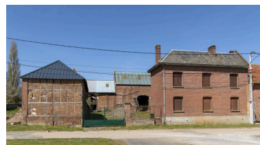
Ferme avec logis sur rue et bâtiments agricoles, n°38 rue Principale, vue depuis l'est. Phot. Marc Kérignard IVR32_20216000331NUCA
