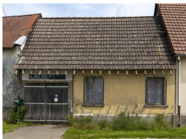
Logis avec passage charretier sur rue (ancienne maison de serger?), n°95 rue Principale, vue depuis l'ouest. Phot. Marc Kérignard IVR32_20216000526NUCA
