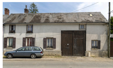
Logie avec passage charretier sur rue (ancienne maison de serger?), n°7 rue d'En-Bas, vue depuis l'ouest. Phot. Marc Kérignard IVR32_20216000529NUCA
