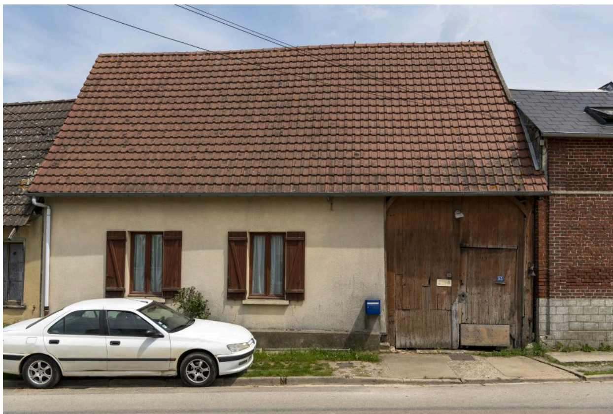
Logis sur rue avec passage charretier (ancienne maison de serger?), n°93 rue Principale, vue depuis l'ouest.
