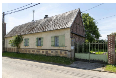
Logis sur rue, n°3 rue de la Grange aux Genêts, vue depuis le nord-est. Phot. Marc Kérignard IVR32_20216000518NUCA
