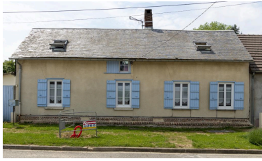
Logis sur rue, n°8 rue d'En-Bas, vue depuis l'est. Phot. Marc Kérignard IVR32_20216000530NUCA
