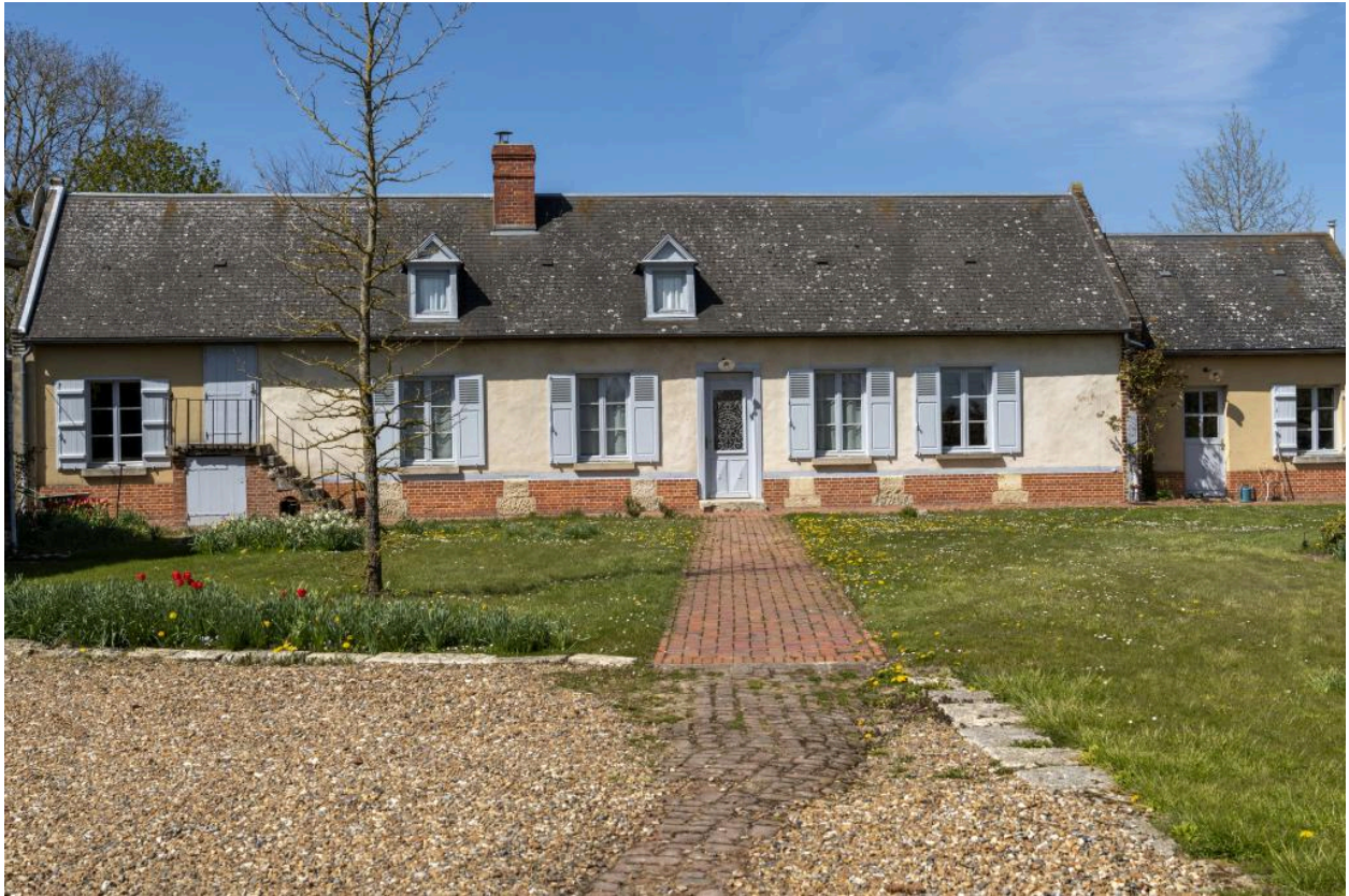
Logis, n°54 rue Principale, vue depuis l'est.
