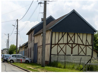
Pignon d'une grange en pans de bois avec essentage en ardoise, n °10 rue d'En-Bas, vue depuis le nord. Phot. Marc Kérignard IVR32_20216000533NUCA
