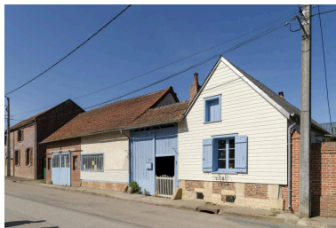
Ancien atelier de forgeron, passage charretier et pignon du logis sur rue, n°50 rue Principale, vue depuis l'est. Phot. Marc Kérignard IVR32_20216000312NUCA
