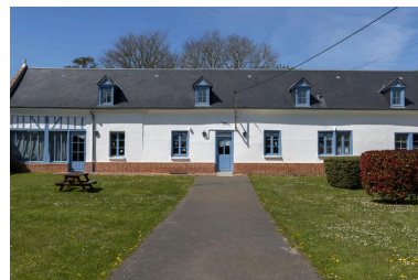
Ancien presbytère, n°52 rue Principale, vue depuis l'est. Phot. Marc Kérignard IVR32_20216000340NUCA
