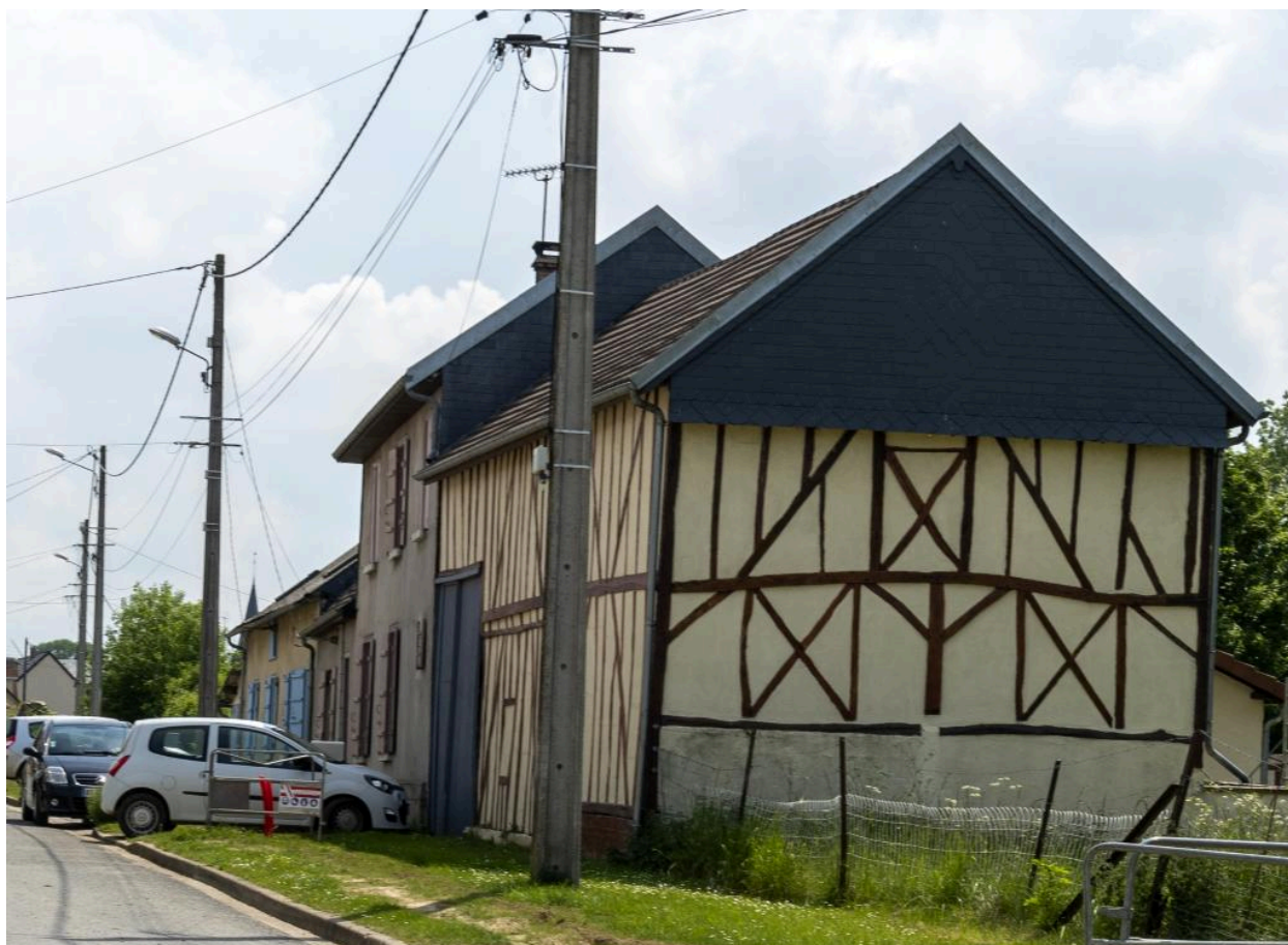
Pignon d'une grange en pans de bois avec essentage en ardoise, n°10 rue d'En-Bas, vue depuis le nord.
