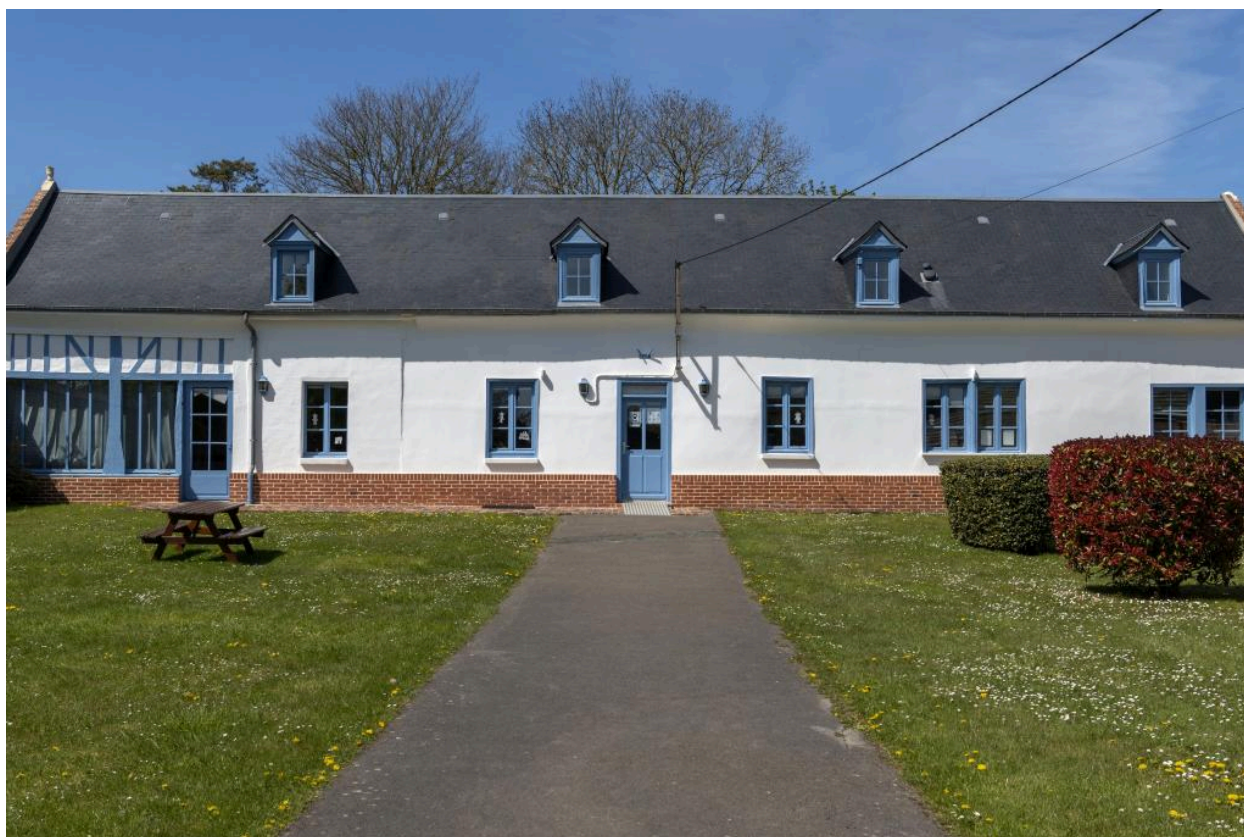
Ancien presbytère, n°52 rue Principale, vue depuis l'est.
