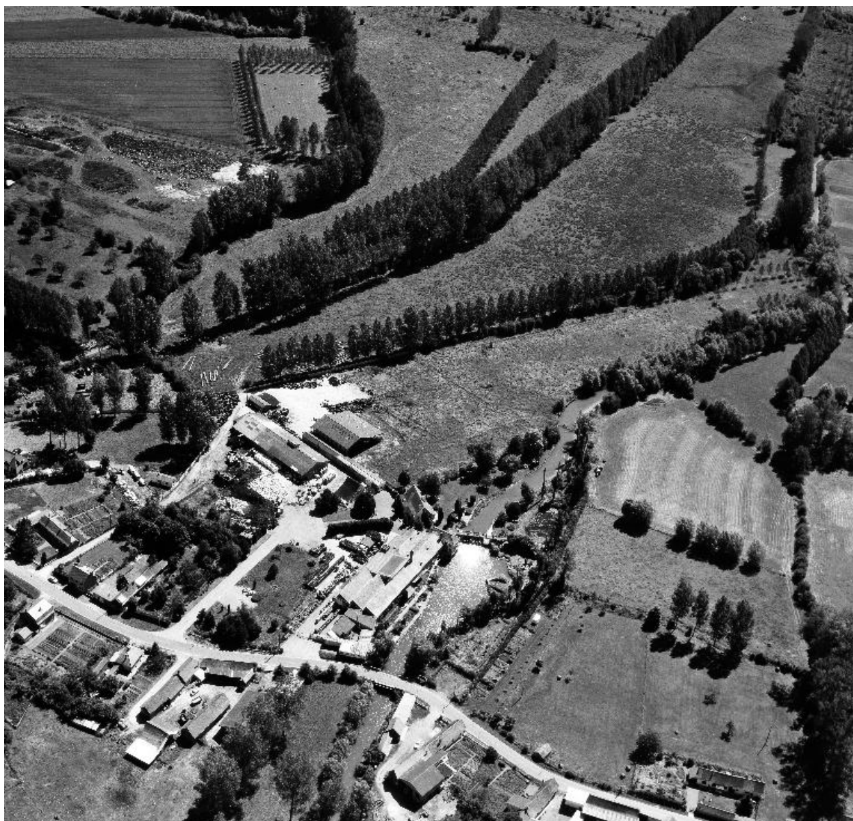
Vue aérienne, flanc nord-ouest.
