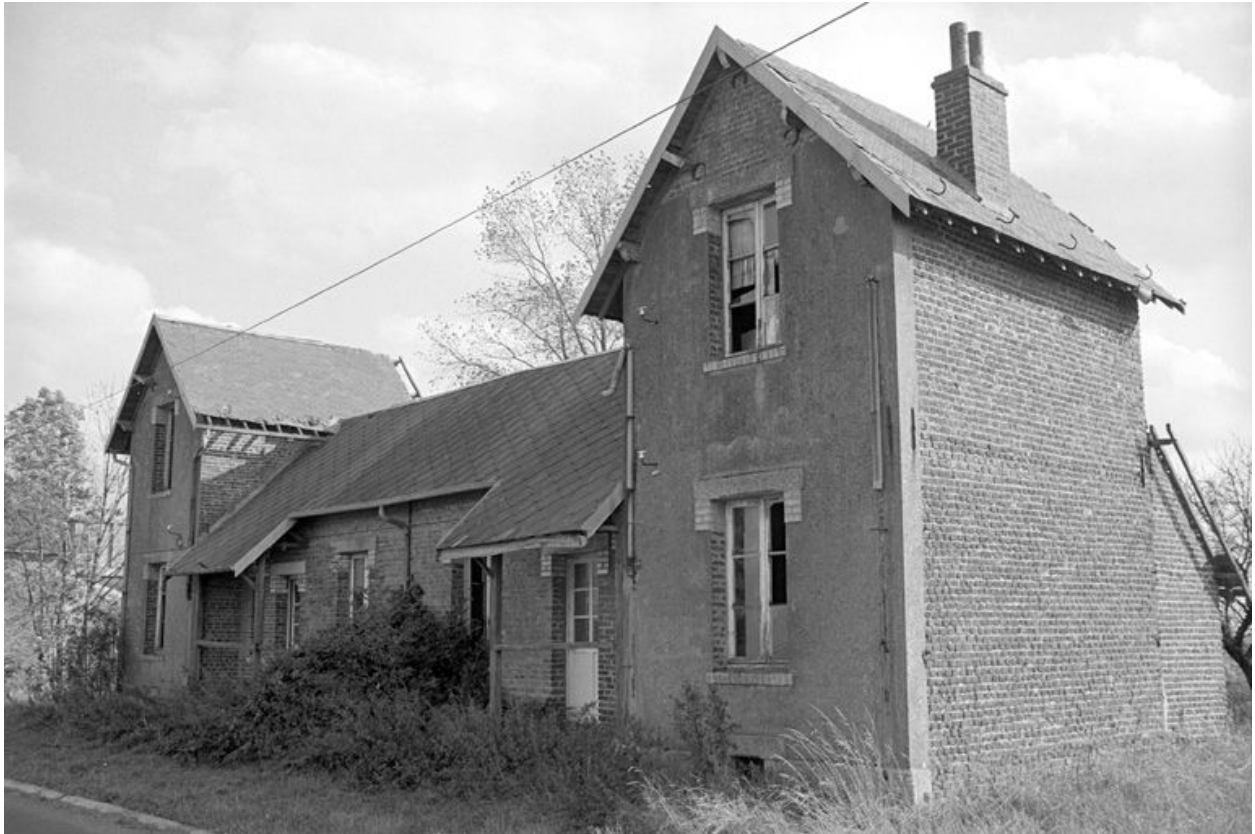
Logement d'ouvriers, vue générale, élévation antérieure.
