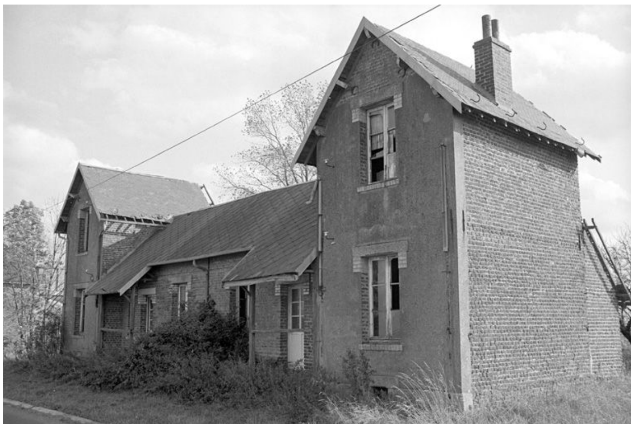
Logement d'ouvriers, vue générale, élévation antérieure.
