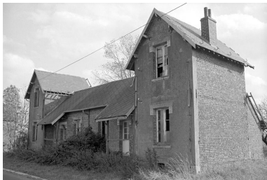
Logement d'ouvriers, vue générale, élévation antérieure.
